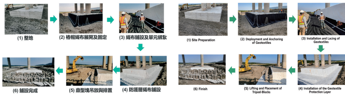
鼎型塊織布橋基保護工法施工流程
