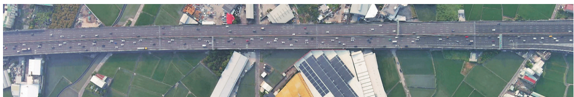
國道3號南下霧峰至霧峰系統路段空拍畫面
