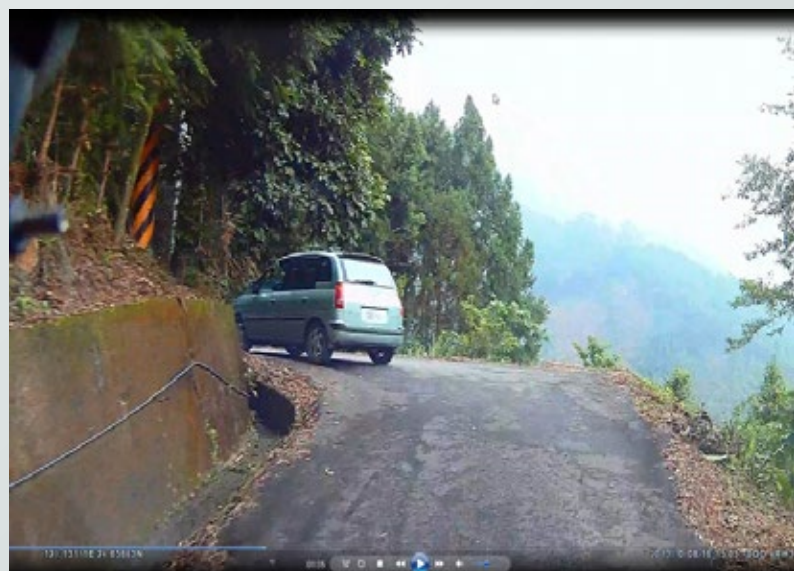
圖 4-17 現況照片 (2)- 彎道缺護欄及反光鏡
