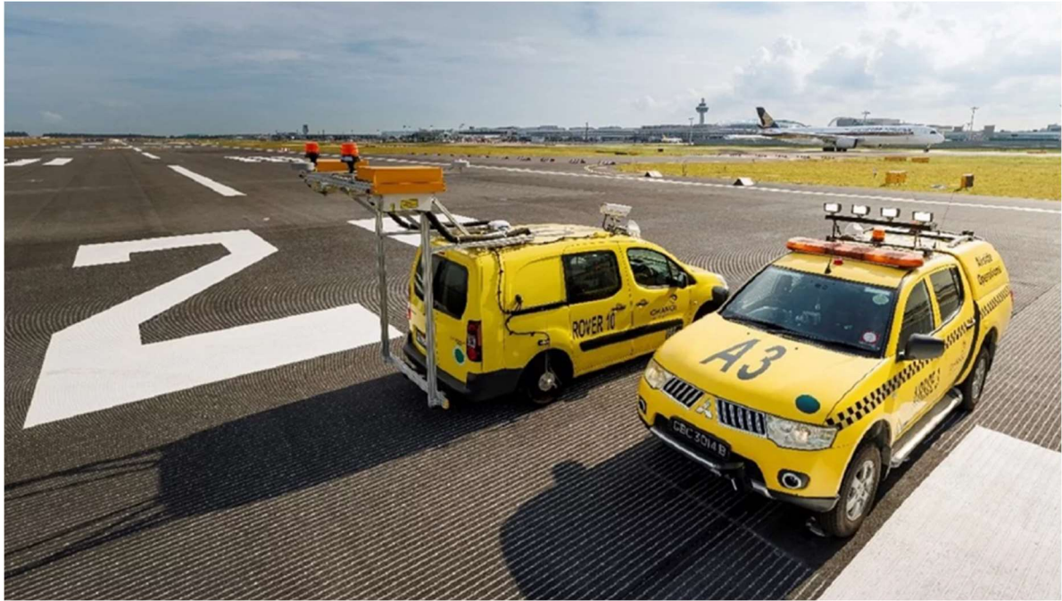
圖 4 新加坡樟宜機場跑道凹槽瀝青鋪面情形
