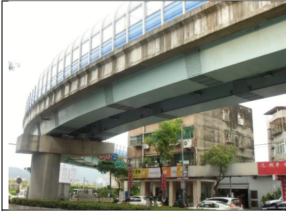
照片 6.3 文湖線 CB430 區段標鋼箱梁橋(P12~P15)
