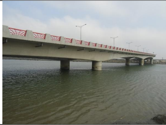
照片 6.4 全橋鋼筋採用熱浸鍍鋅之橋梁(鹿安橋)
