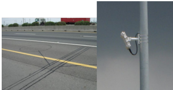
圖 2.1.2 環路線圈式車輛探測器
