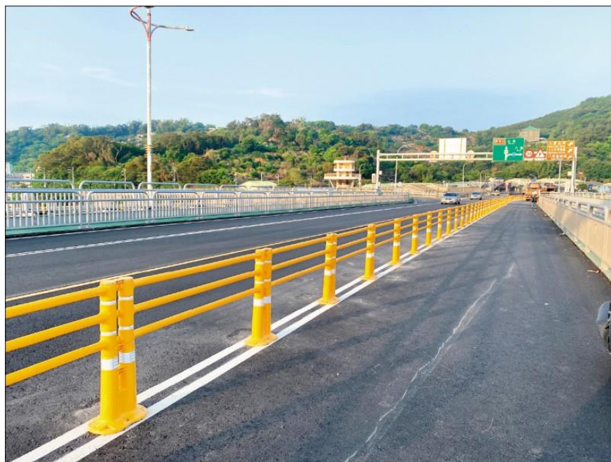
圖 3.3 交通桿加連桿（雙主柱護欄）阻隔設施
