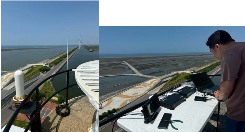
圖 2.13 岸站天線架設與系統架設
