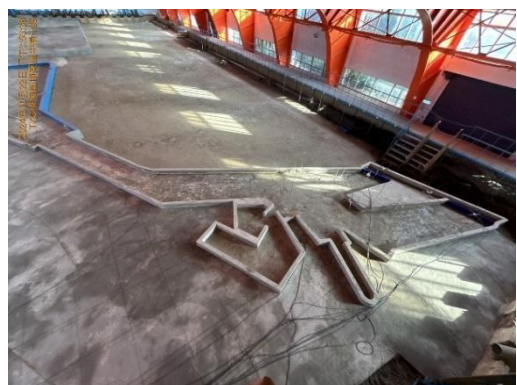
(d) 完成水工模型建構
