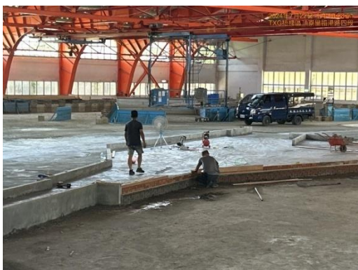
(c) 外港結構物建置
