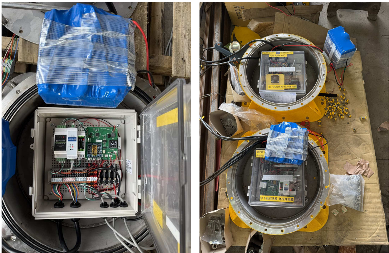
圖4.32 電控箱體安裝配線
