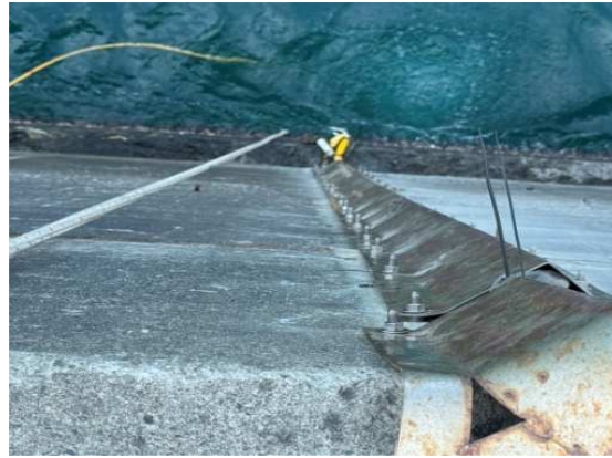
(b) 岸壁纜線保護蓋板設置
