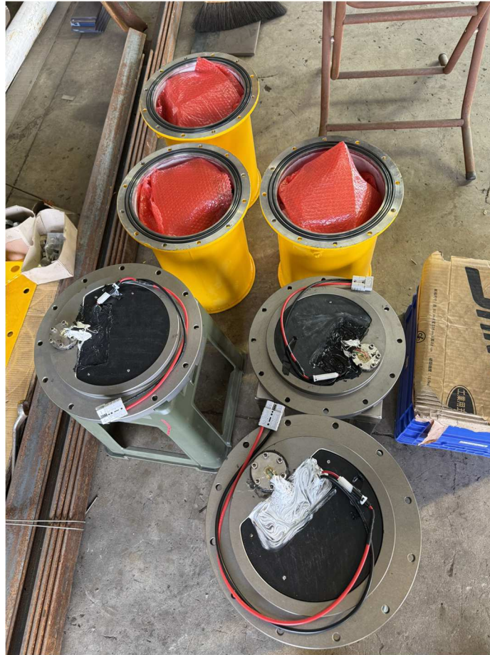
圖4.31 電池模組安裝配線
