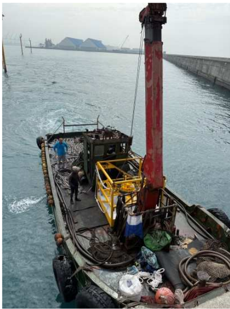
(a) 電纜及近岸端儀器架布放
