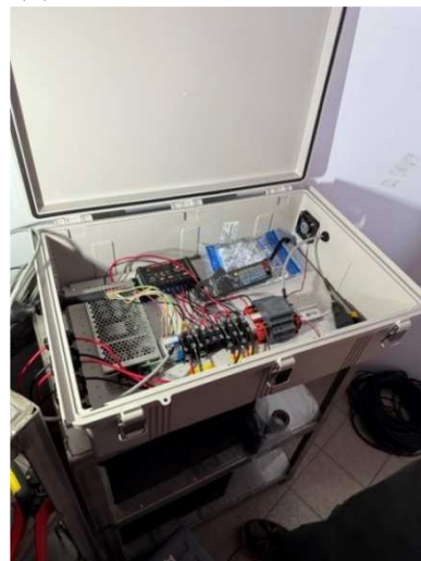
(d) 燈塔內設備安裝配線
