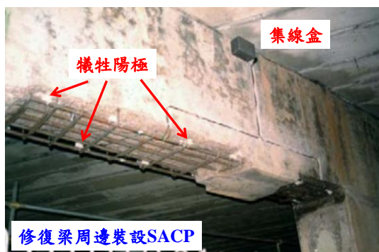
圖 5.8 犧牲陽極式陰極保護系統示意圖及現場施作照片
