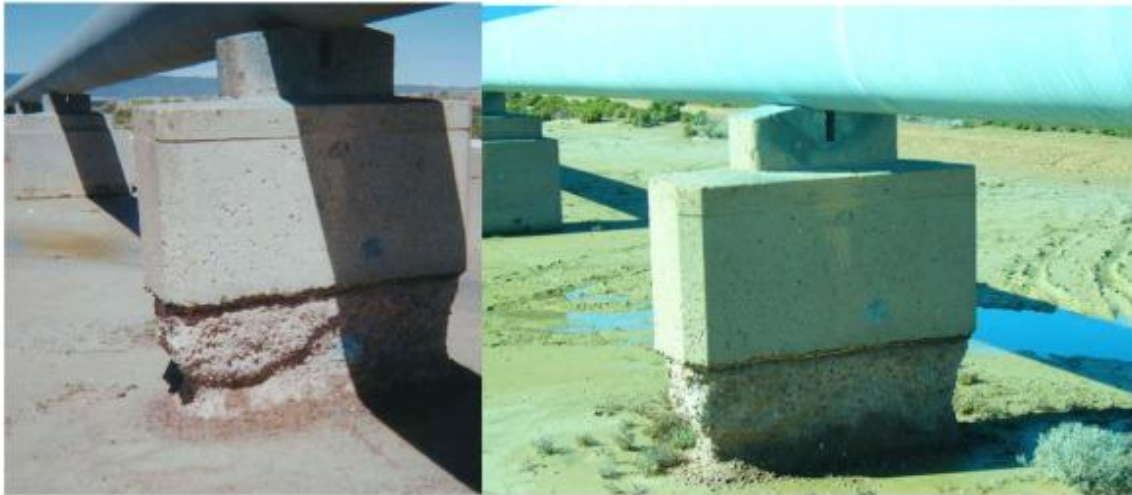
圖 2.2 混凝土基礎因物理性硫酸鹽侵蝕而嚴重劣化
