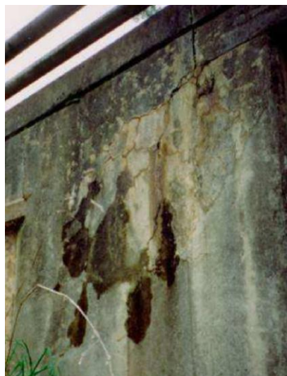
圖 2.3 混凝土因鹼質與粒料反應造成之裂縫及剝落
