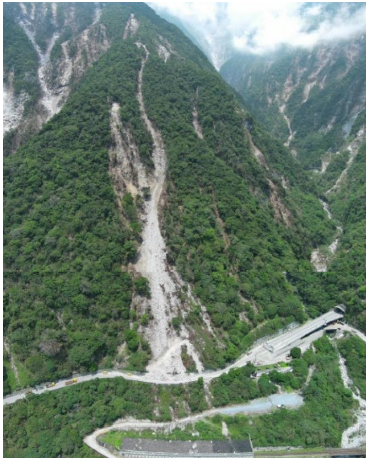
圖 3.13 台 9 線 158.3K 邊坡於 0403 地震後之災害
