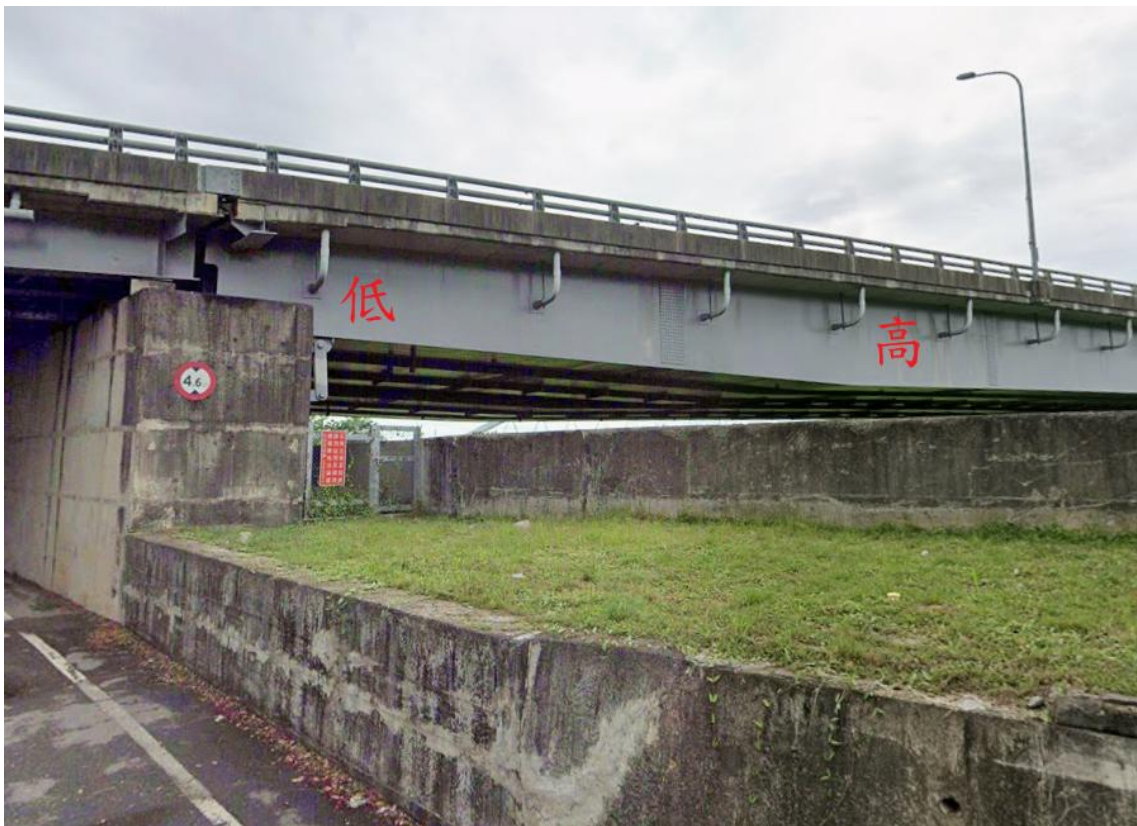
圖 4.15 軍功橋鋼箱梁之內部高度漸變示意圖
