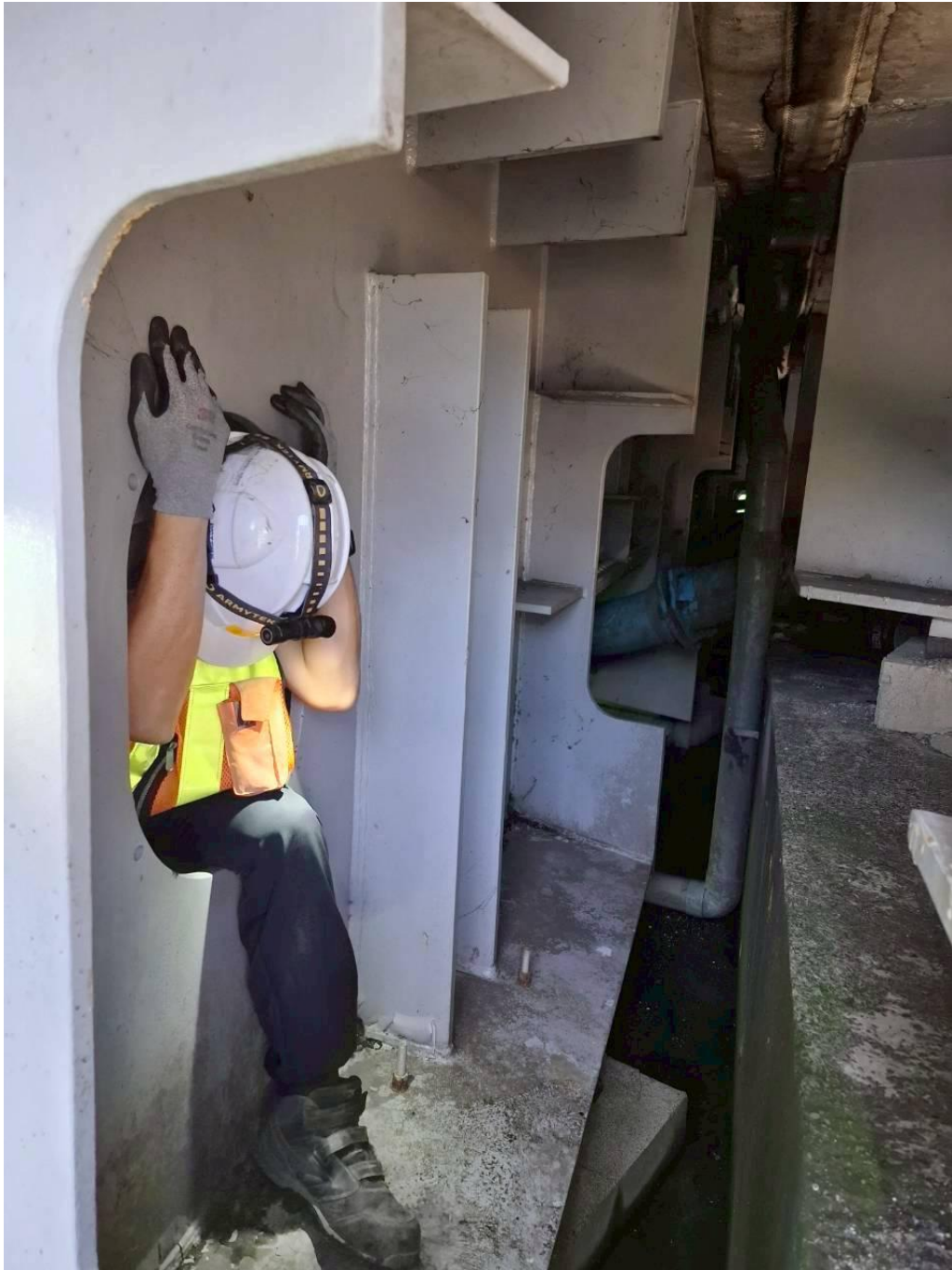
圖 4.14 人員進入鋼箱梁之橋側人孔
