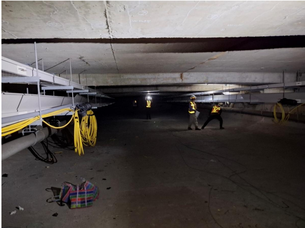
圖 4.4 預力混凝土(PC)箱梁內部
