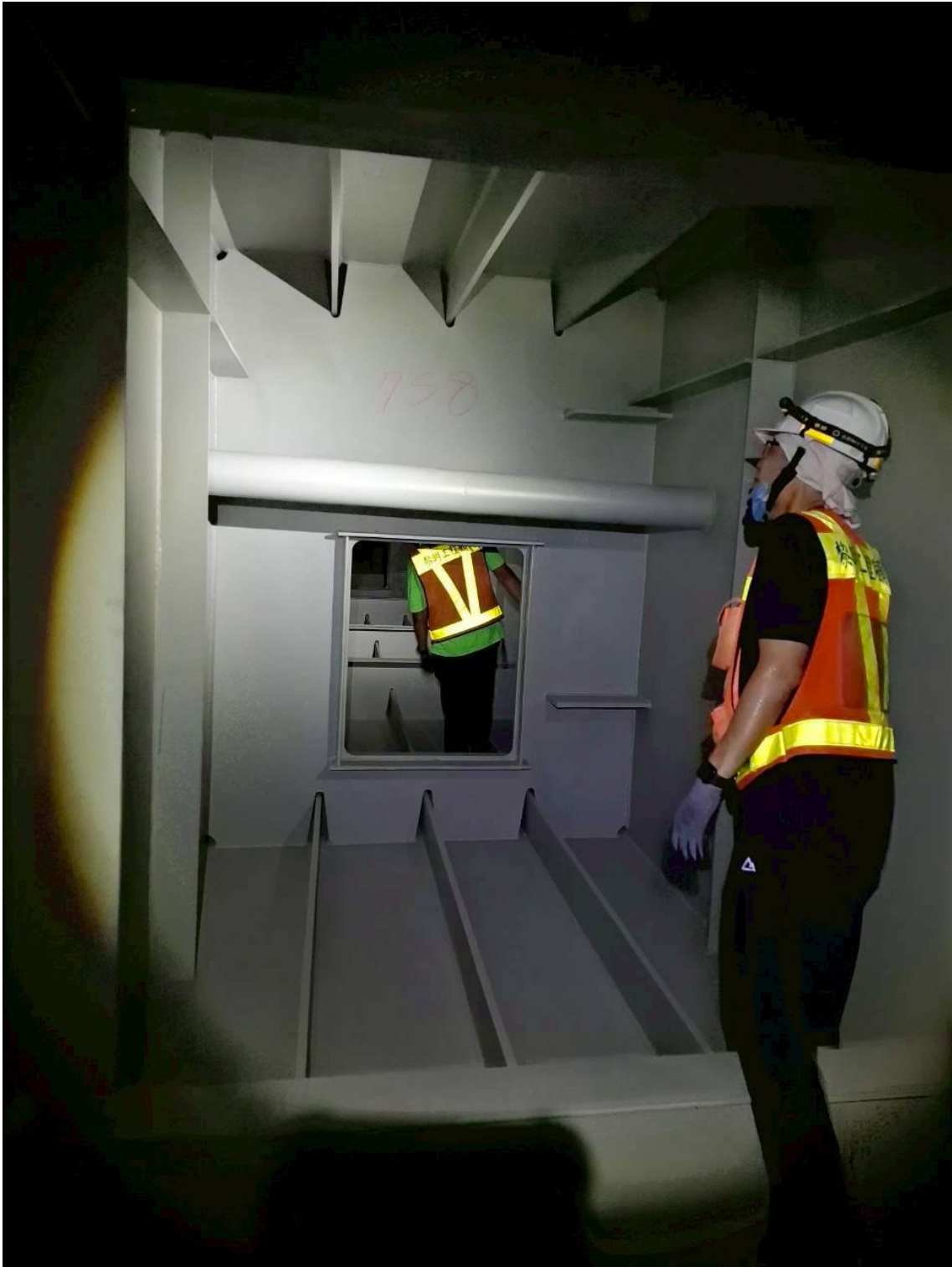
圖 4.17 鋼箱梁高度漸高人員可直立移動
