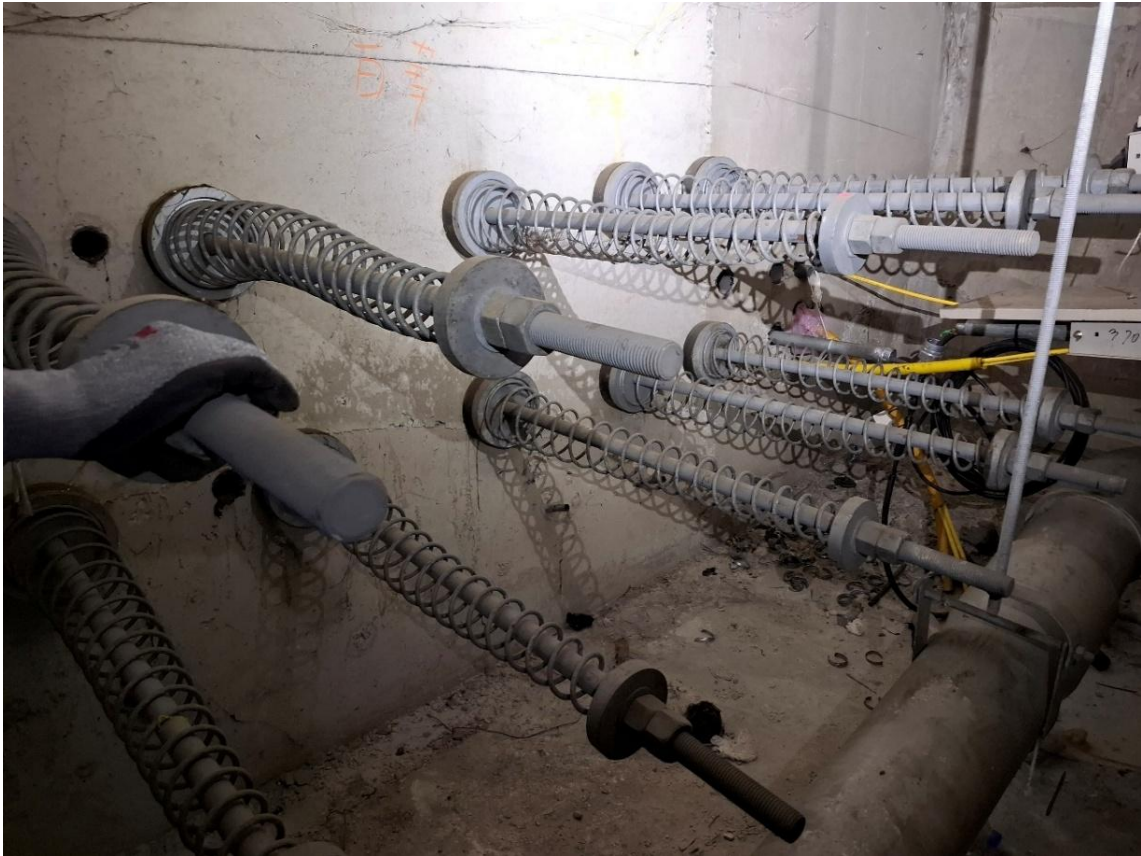
圖 4.8 橋梁之防落設施
