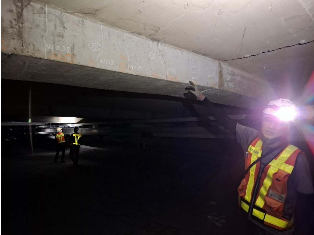
圖 4.9 箱梁內橫向之混凝土梁
