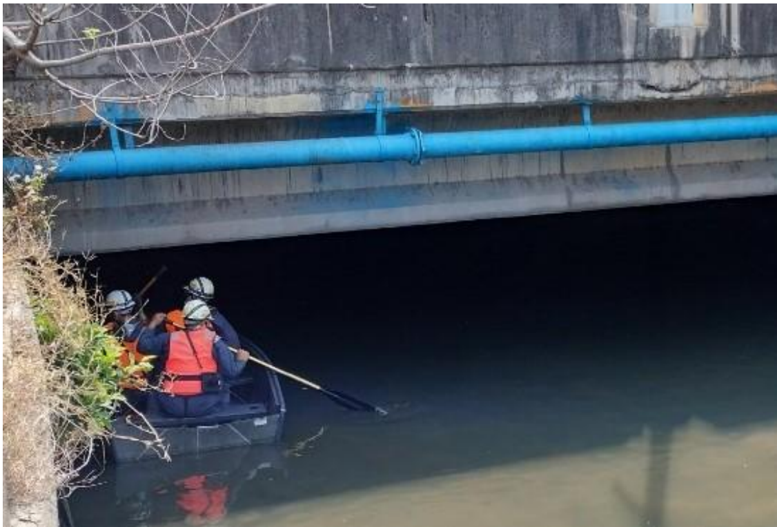
圖 1.1 橋檢人員搭乘船艇進入橋梁梁底目視檢測
