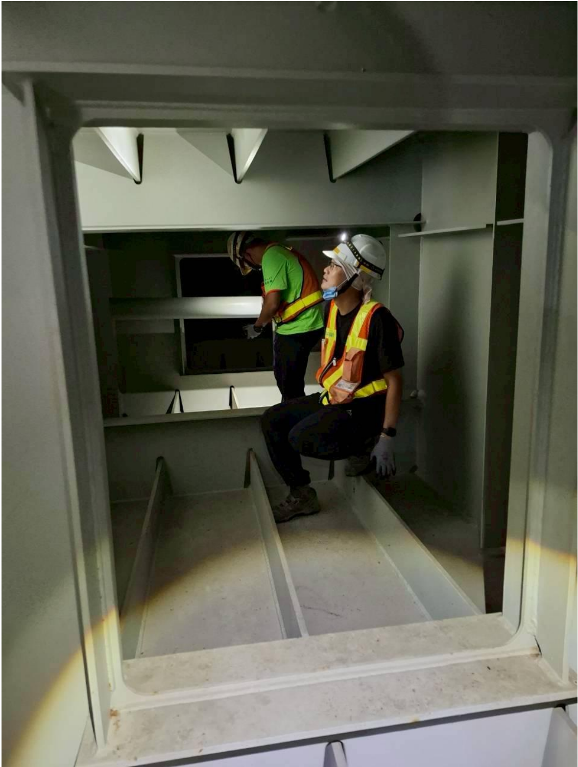
圖 4.16 鋼箱梁前段高度較低人員需半蹲彎腰移動
