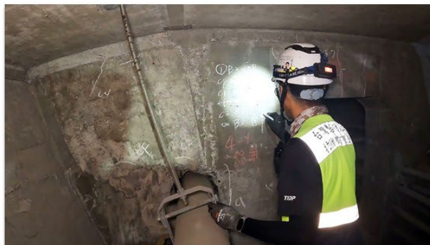
橋檢人員檢測箱梁內部
