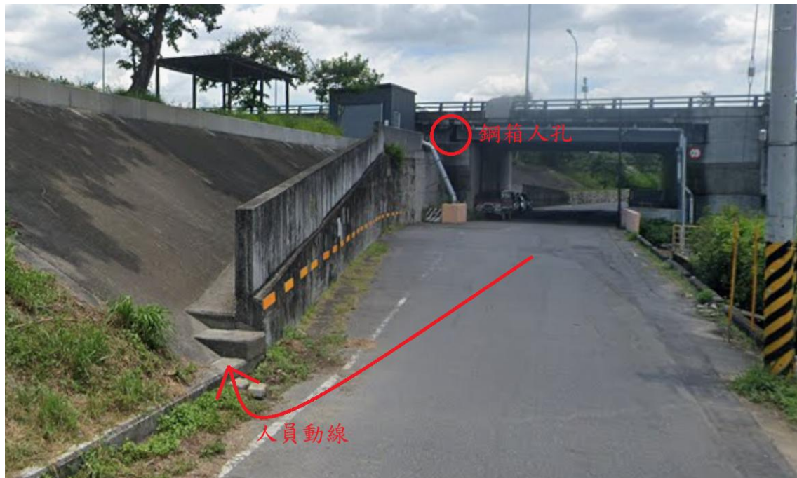
圖 4.13 進入軍功橋鋼箱梁內部之人員步行路線
