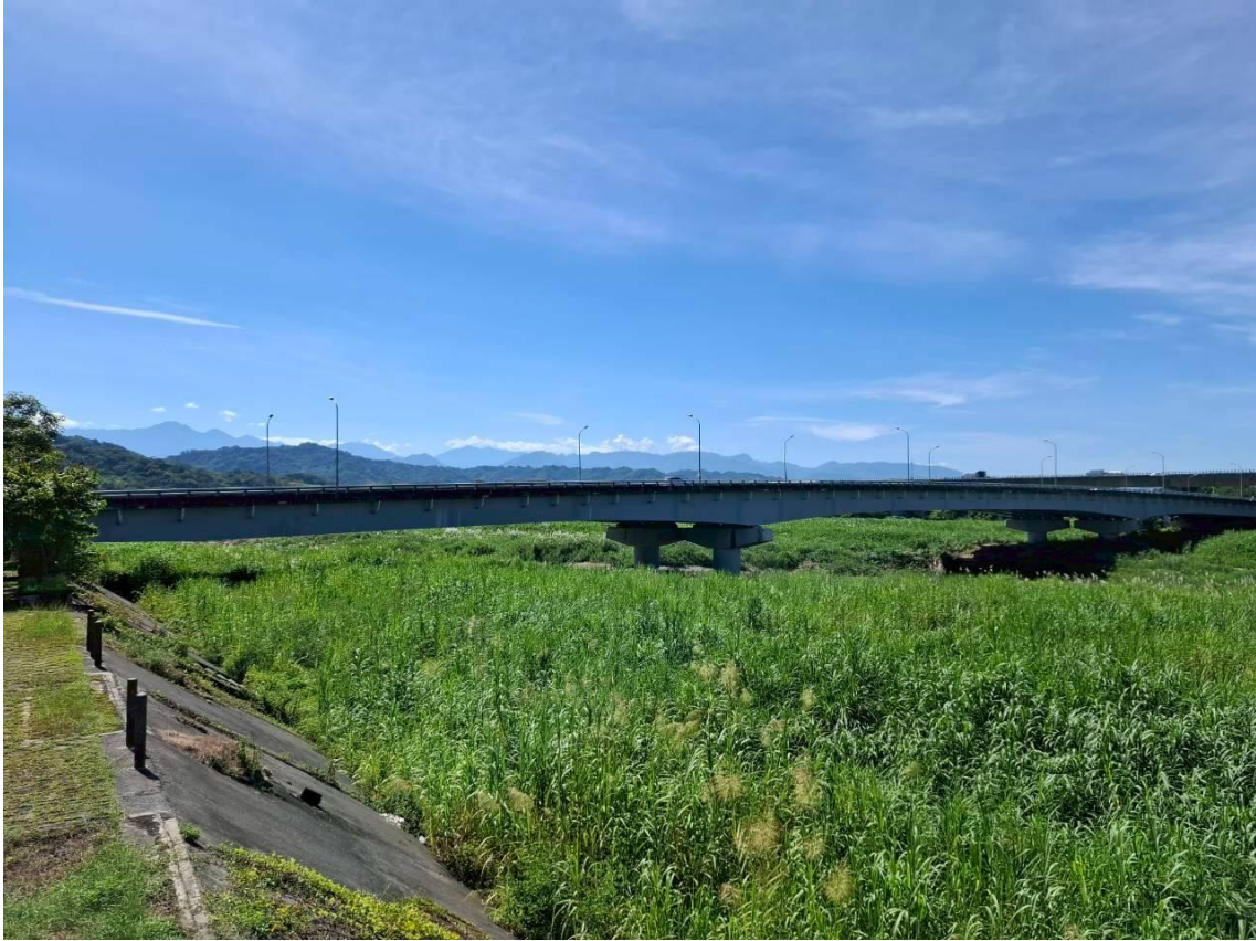
圖 4.12 南投市軍功橋橋梁外觀
