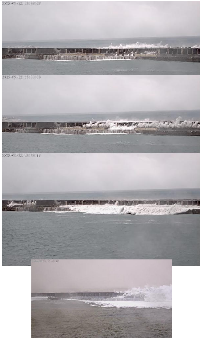
圖 2.14 花蓮港東防波堤於 2025 年樺加沙颱風期間的日間越波影像
