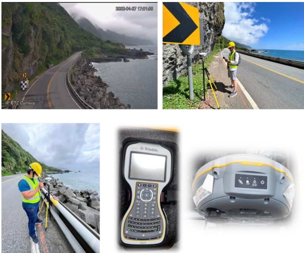
圖 3.25 現場量測及量測工具
