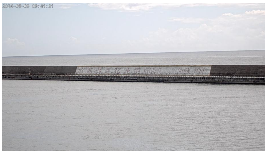
圖 3.39 花蓮港區防波堤破損前
