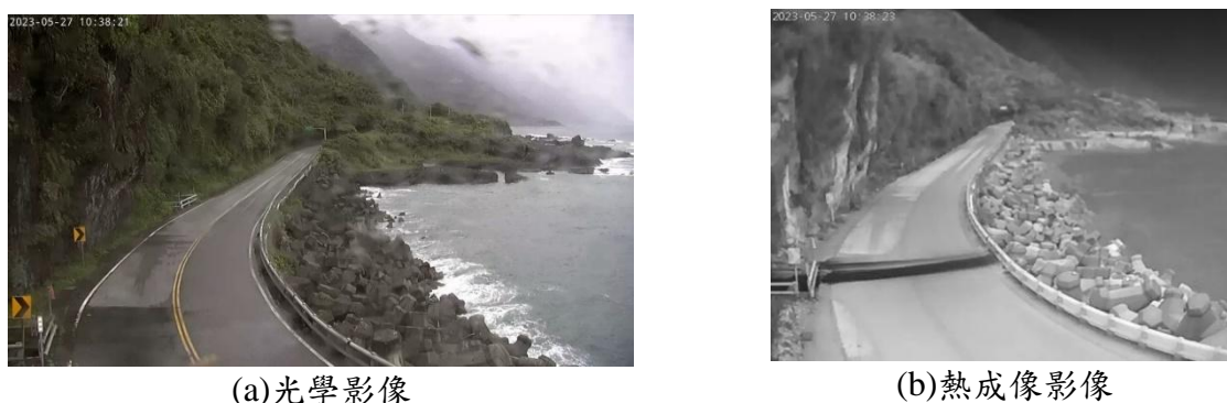
圖 2.1 海岸公路人定勝天路段日間未降雨影像(瑪娃颱風)
