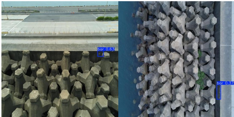
圖 6.71 鋼筋裸露偵測結果
