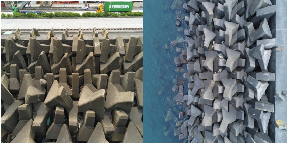
圖 6.66 臺北港堤面影像圖
