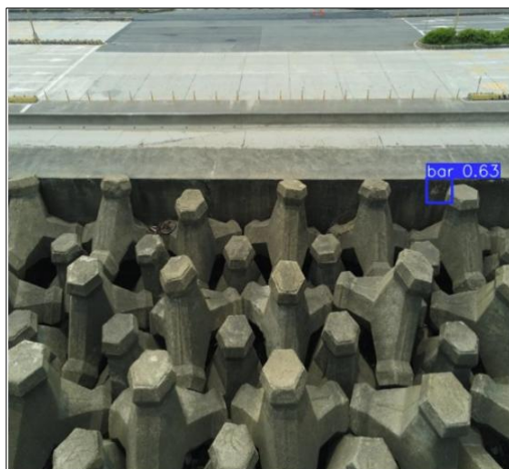
圖 9.30 鋼筋裸露影像辨識成果(局部異狀示意)
