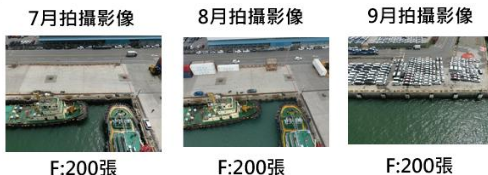
圖 6.90 堤岸表面裂化檢測資料集來源
