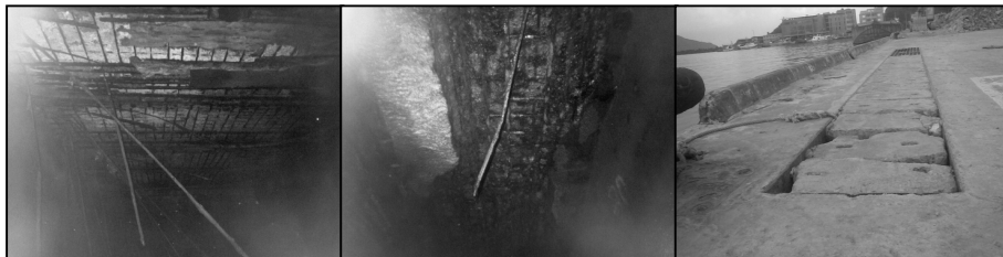
面版底部版破損情形
