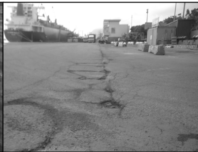
碼頭AC鋪面裂縫情形
