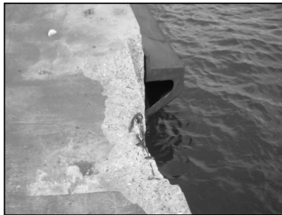
岸壁混凝土剝落情形
