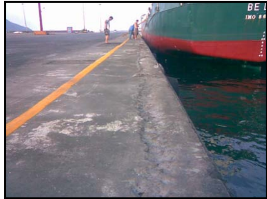
b.碼頭岸壁與面版間裂縫
