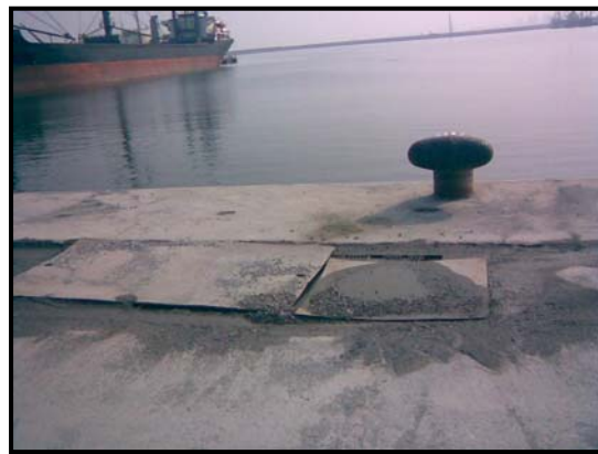
d.碼頭碼頭後線沉陷情形 3
