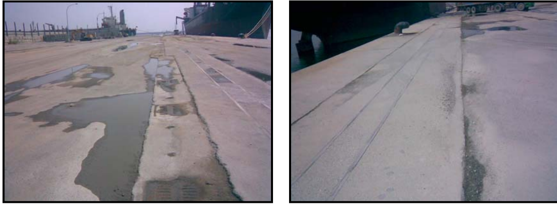
a.碼頭後線裂縫及沉陷情形
