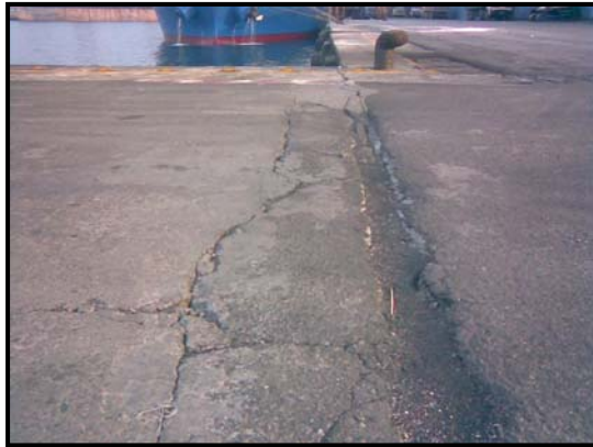
a.碼頭路面裂縫情形
