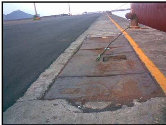
c.繫船柱與幾排水設備生鏽情形
