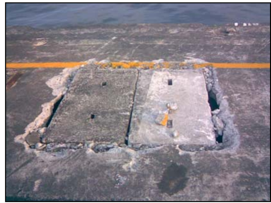
d.碼頭混凝土蓋版缺陷
