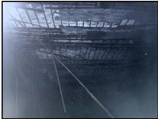
a.面版底部混凝土版剝落、鋼筋腐蝕 1
