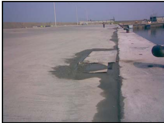
b.碼頭碼頭後線沉陷情形 1
