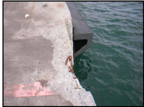
b.碼頭岸壁混凝土剝落情形
