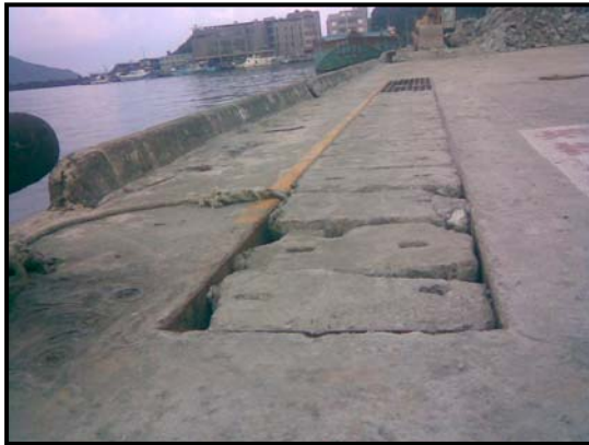
e.碼頭給水排水設備保護 R.C.蓋版老舊
