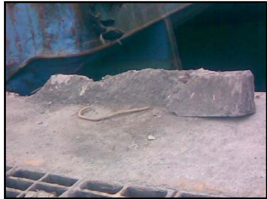
f.碼頭擋車牆破損、劣化
