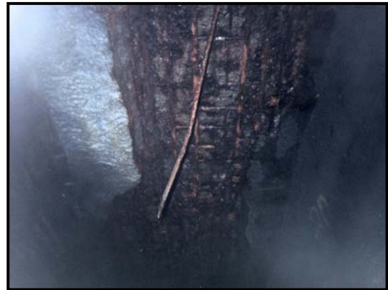
b.面版底部混凝土樑剝落、鋼筋腐蝕 2
