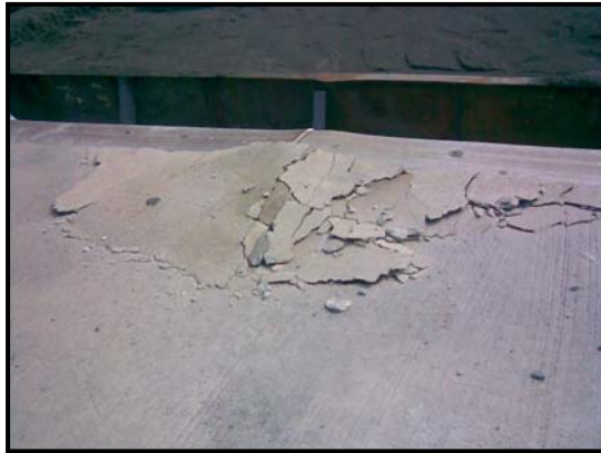
a.碼頭面版混凝土剝落情形
