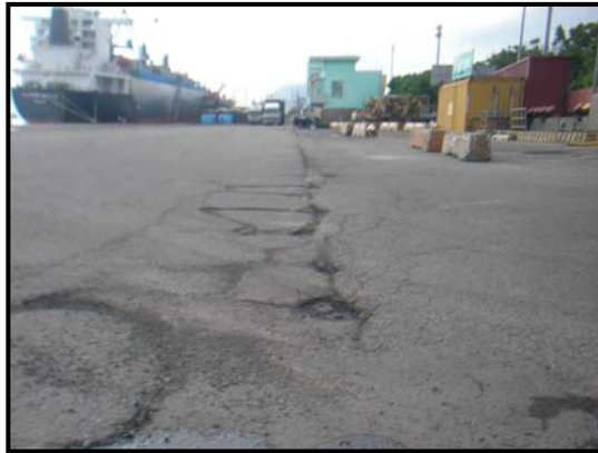
a.碼頭 AC 鋪面裂縫情形
