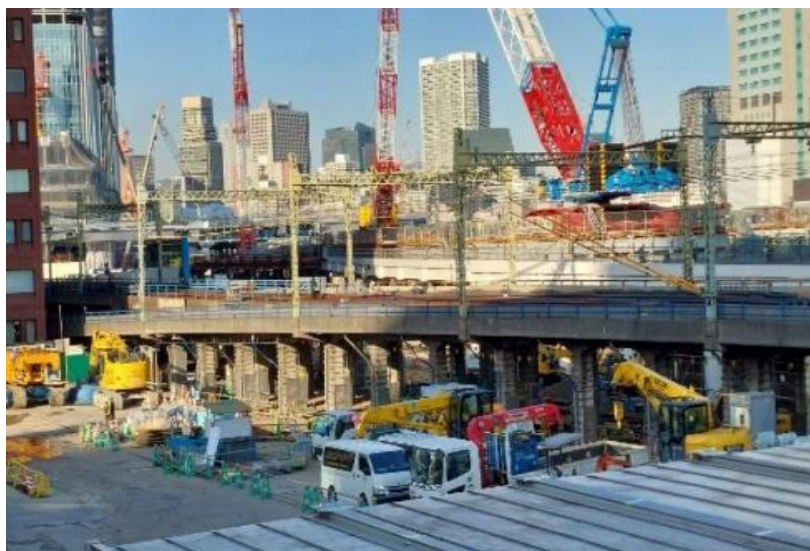
圖 19 品川站北側臨時軌樁施工中
