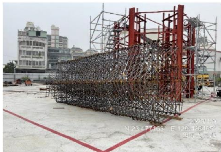
圖 4 預組鋼筋籠工法
