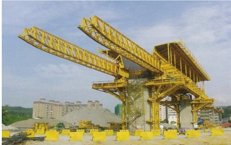
圖 7 高速鐵路路線結構工程 C215 標
