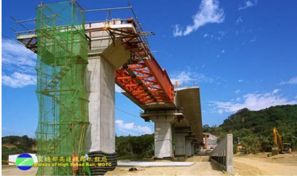
圖 9 高速鐵路路線結構工程 C260 標
