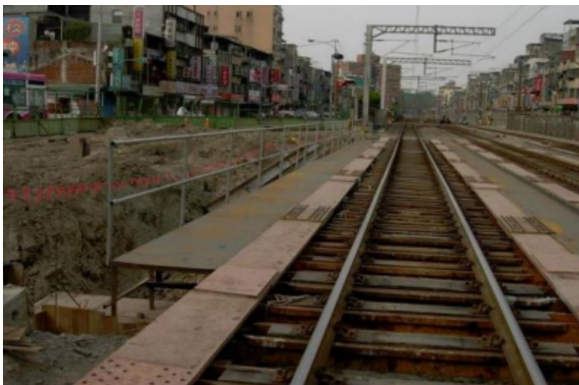
圖 1 抱枕工法施作示意圖
