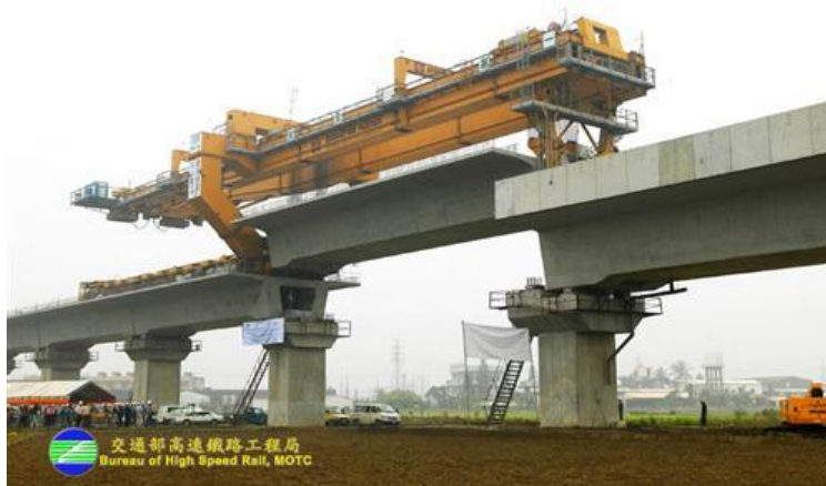
圖 6 高速鐵路路線結構工程 C280 標
