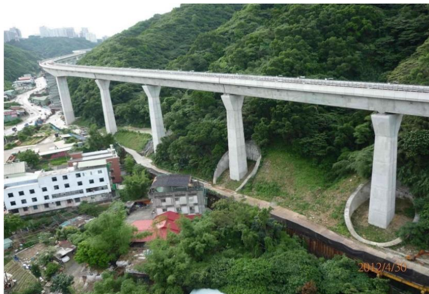
圖 11 竹削工法
