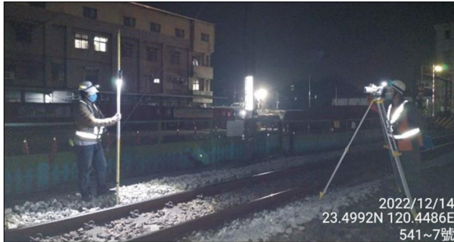
圖 13 沉陷釘工法
