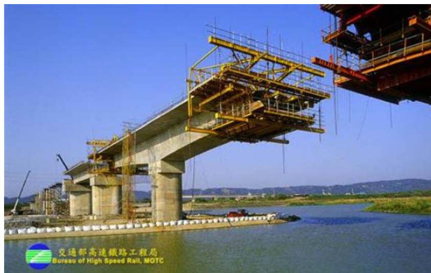
圖 8 高速鐵路路線結構工程 C220 標
