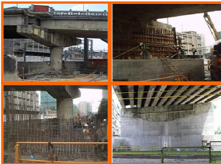
圖 2 南港專案東新橋北墩柱托底施工照片
