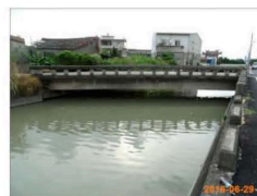
梁底與河面相當接近
