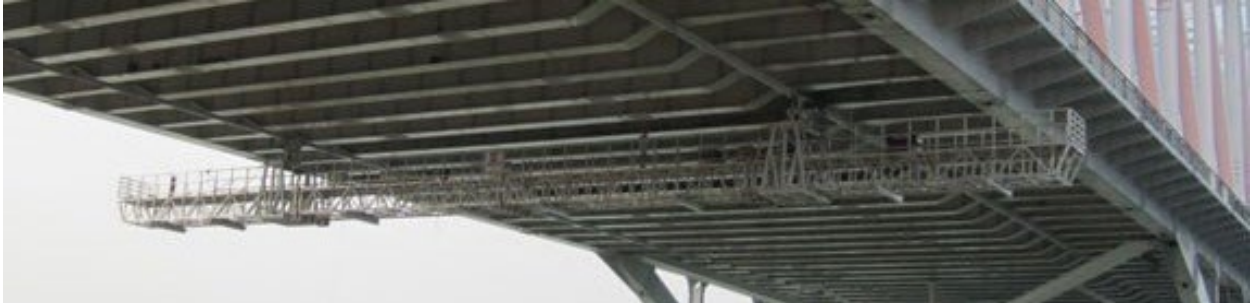
圖 2.3 固定式桁架通道橋梁檢測工具
