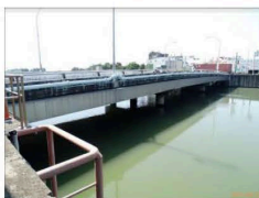
橋梁外側附掛物及路燈
