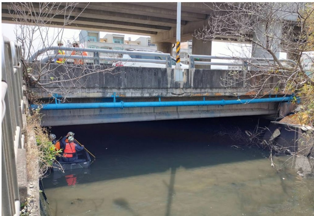
圖 1.3 橋檢人員搭乘船艇檢測
