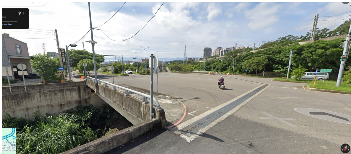
圖 4.5 新竹市公道五路_公道五路橋
