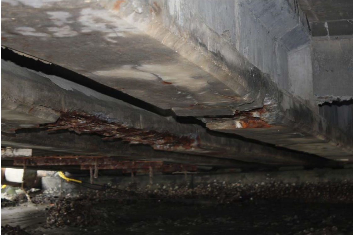
圖 1.1 台 17 線臺南北門段鯤鯓橋橋梁底座鏽蝕與龜裂現象
