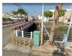
橋梁旁的管線設施及上方的電線
