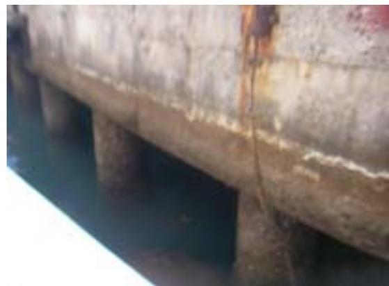
(4) 1 號碼頭第 7 單元電位測試裝置生鏽
