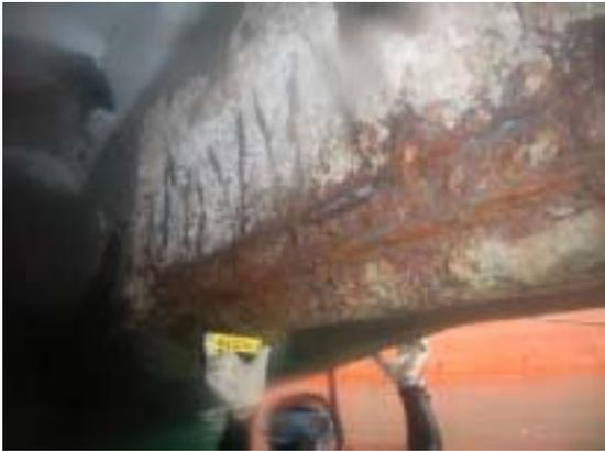
(3) 底樑鋼筋腐蝕生銹、混凝土剝落 2
