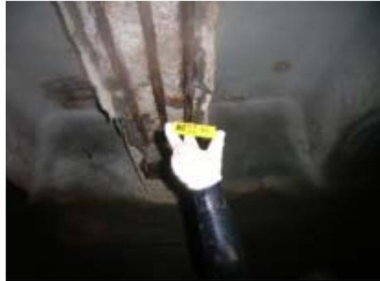
(2) 底樑鋼筋腐蝕生鏽、混凝土剝落 1
