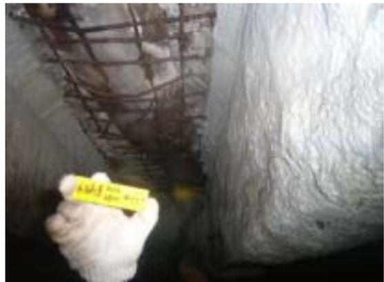
(6) 面版鋼筋腐蝕生銹、混凝土剝落 3
