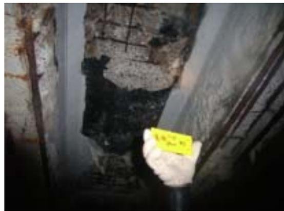
(3) 面版鋼筋腐蝕生鏽、混凝土剝落 2
