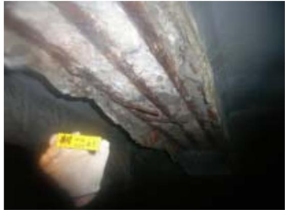
(4) 底樑鋼筋腐蝕生銹、混凝土剝落 3
