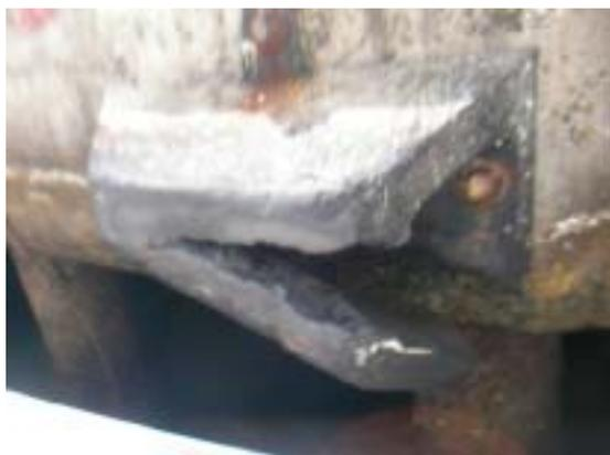
(5) 1 號碼頭第 7 單元護舷碰墊破損
