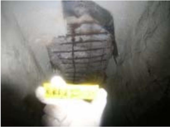
(1) 面版鋼筋腐蝕生銹、混凝土剝落 1
