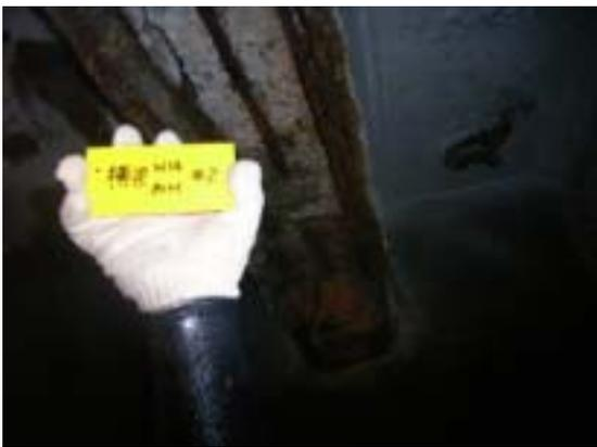
(3) 底樑鋼筋腐蝕生鏽、混凝土剝落 4
