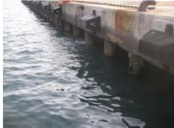
(2) 1 號碼頭第 1 單元基樁混凝土剝落
