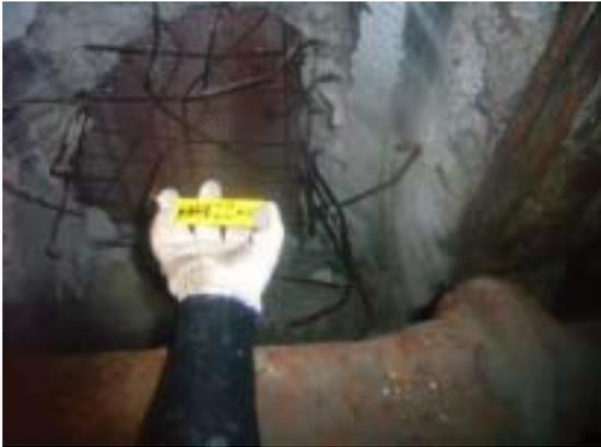
(1) 面版鋼筋腐蝕生鏽、混凝土剝落 1
