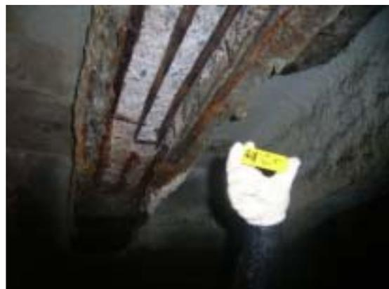
(4) 底樑鋼筋腐蝕生鏽、混凝土剝落 3
