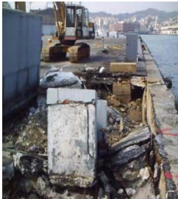
圖3.28 基隆港東5碼頭岸壁崩塌傾斜情形
