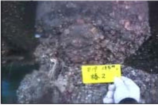
(1) 13.5m 處基樁混凝土劣化情形
