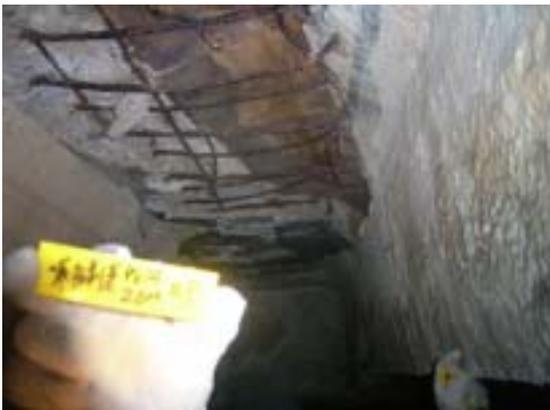
(5) 面版鋼筋腐蝕生銹、混凝土剝落 2
