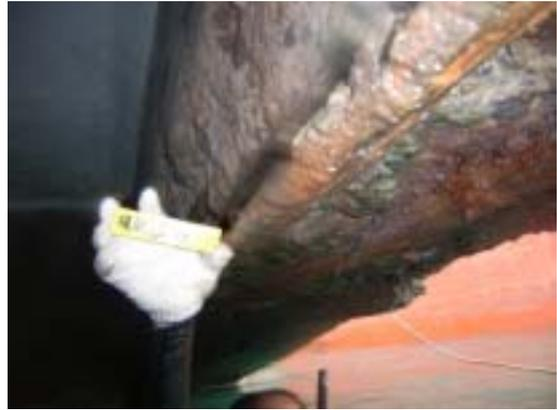
(2) 底樑鋼筋腐蝕生銹、混凝土剝落 1
