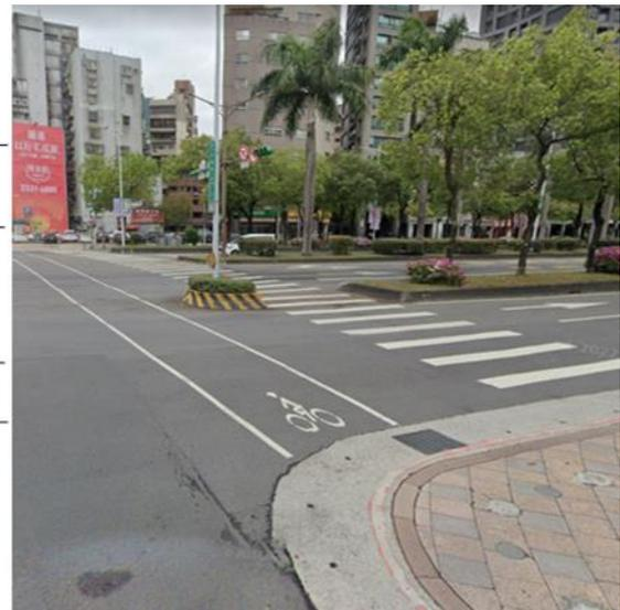
圖 11-3 自行車穿越道與行穿線合併（分離式）
