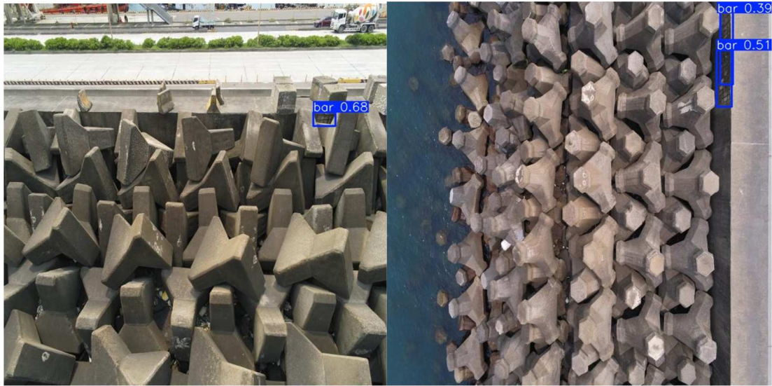
圖 6.59 鋼筋裸露偵測結果
