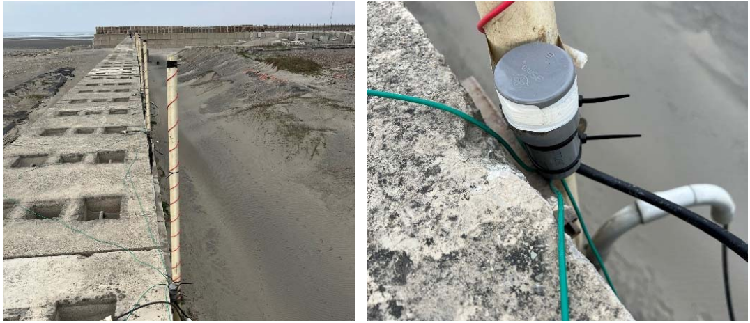
圖 3.16 雷達天線更換情形
