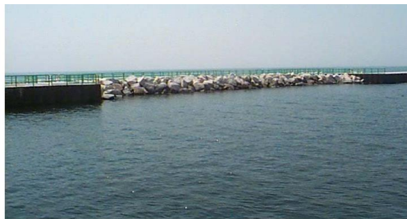
圖 2.30 密西根州 Pentwater 的口袋型消波灘(Thompson et al., 2004)
