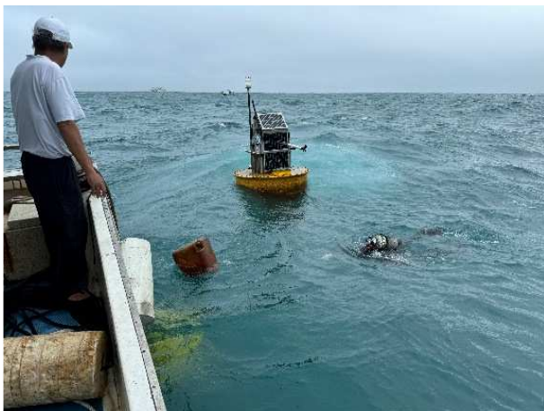
(b) 外海箱體下水作業(左)、水下安裝作業(右)
