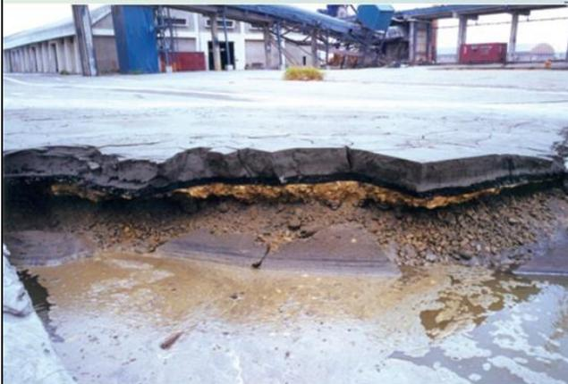
土壤液化後作業區積砂狀況
