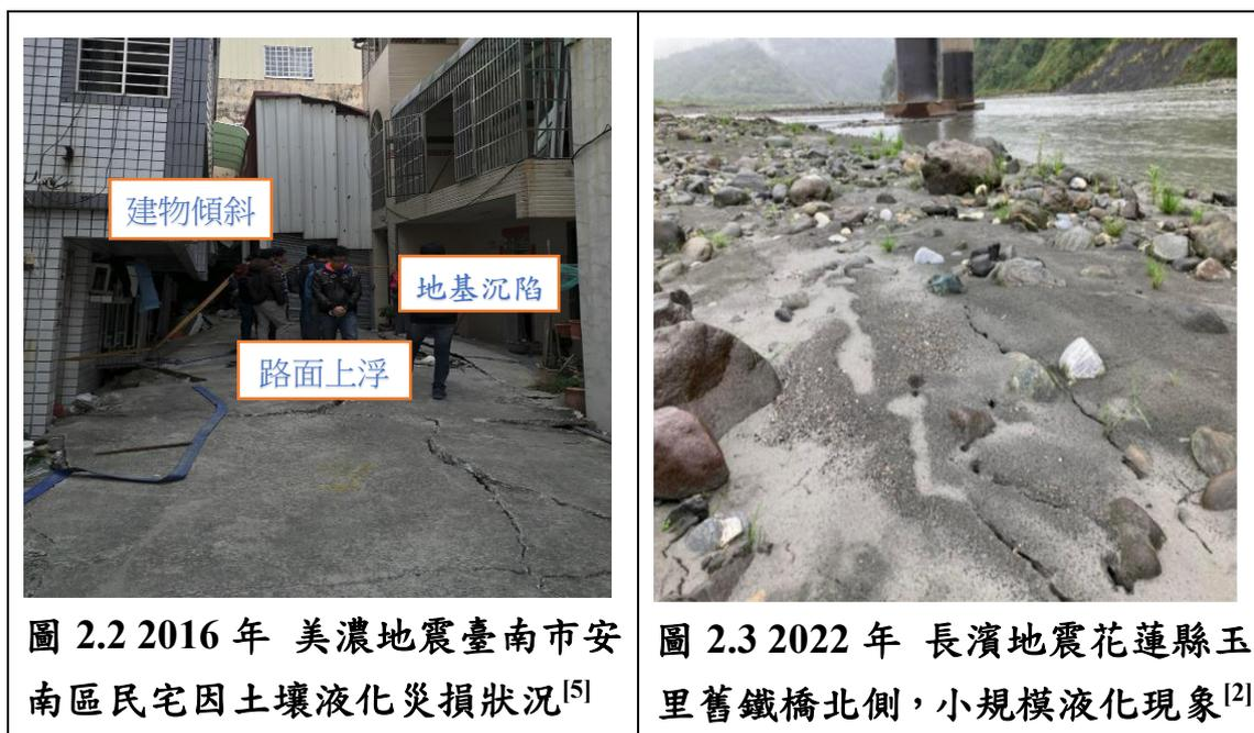
圖 2.2 2016 年 美濃地震臺南市安南區民宅因土壤液化災損狀況<sup>[5]</sup>
