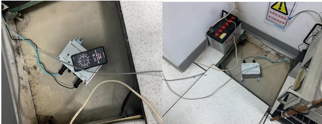
圖 6.3 布袋港 CV374 型地震儀更新安裝示意圖
