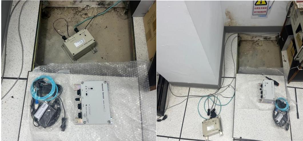
圖 6.2 布袋港舊地震儀(CV373 型)拆除示意圖
