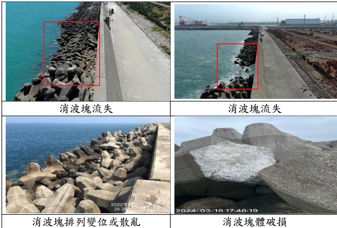
圖 3.5 堤前消波塊構件劣化照片
