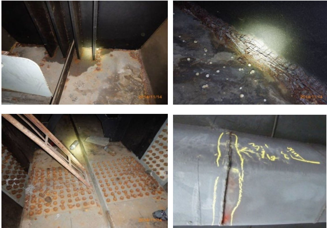
圖 5.9 國內鋼橋箱梁內部嚴重腐蝕及疲勞裂縫案例
