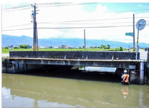
橋檢人員涉水接近目視勘查
