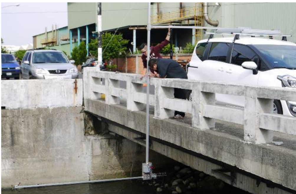
圖 3.2 利用桿件伸縮將影像拍攝裝置送入橋底
