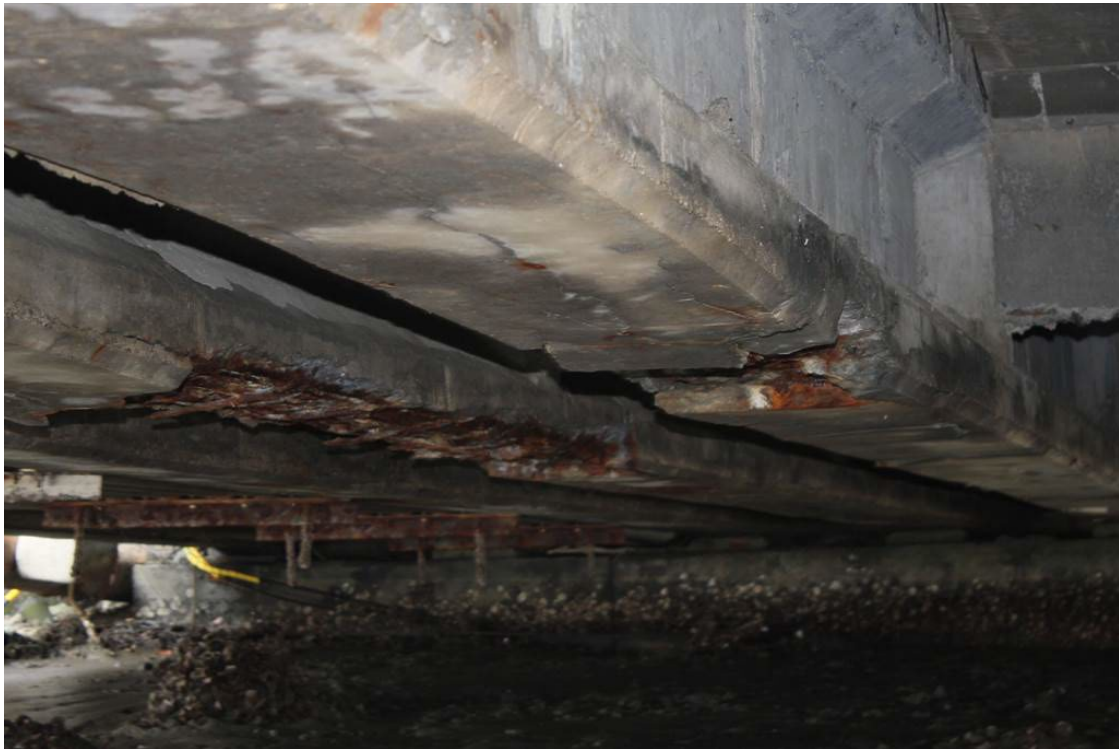
圖 1.3 台 17 線臺南北門段鯤鯓橋橋梁大梁鏽蝕與龜裂(已改建)
