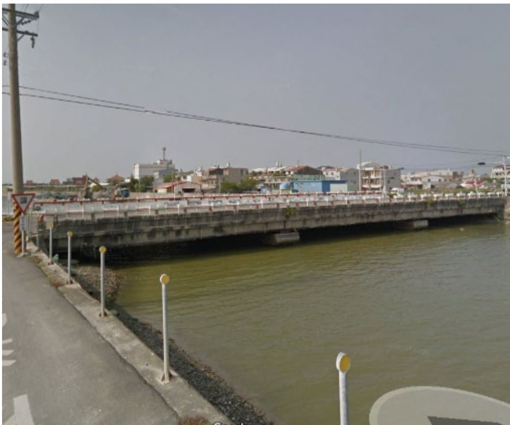
圖 1.4 鯤鯨橋橋梁大梁及橋墩長期浸泡於河中(已改建)
