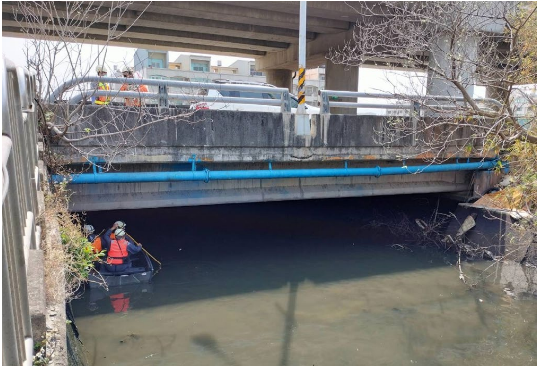
圖 1.1 橋檢人員搭乘船艇檢測
