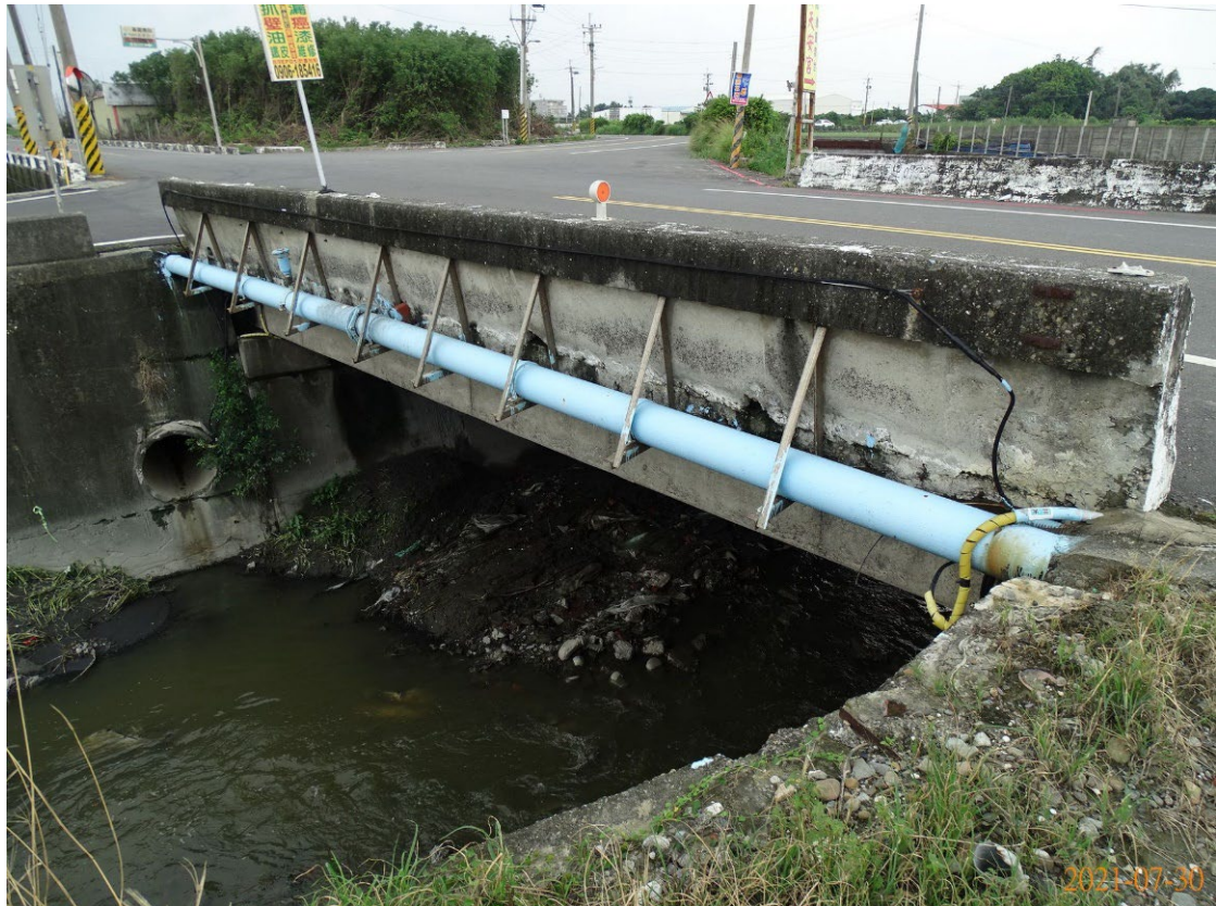
圖 5.3 橋梁護欄外附掛管線
