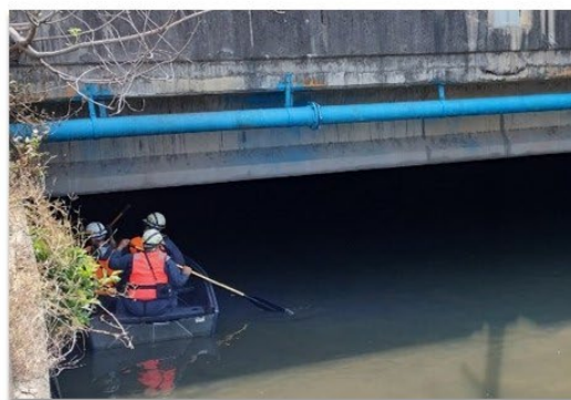
橋檢人員搭乘船艇進入橋梁梁底
