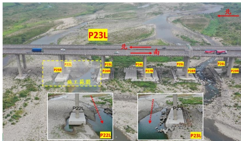
圖 5.18 國 3 大甲溪橋 P22L~P23L 橋基保護工作施工範圍
