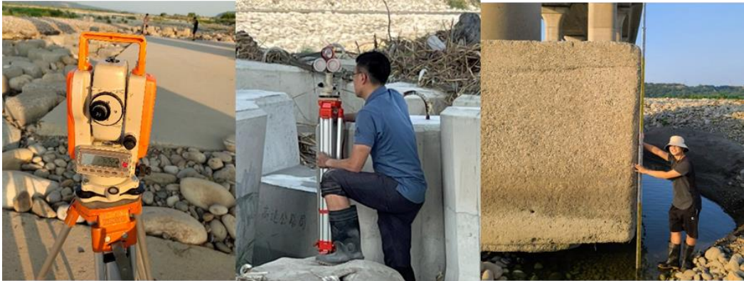
圖 3.4 現場控制測量作業情形
