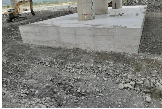
圖 2.30 橋墩基礎下游整地及地形降階
