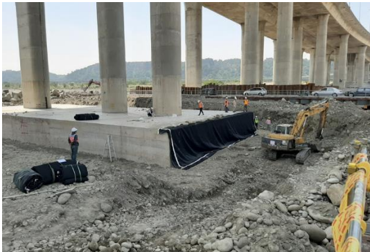
圖 2.31 高強度織布展開並以軟石固定於樁帽上
