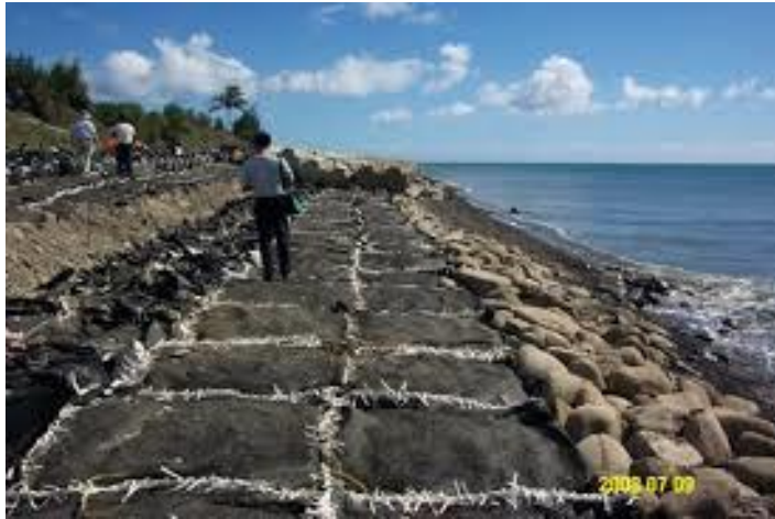
圖 2.4 格網箱籠之海岸保護嘗試性大型試驗現場
