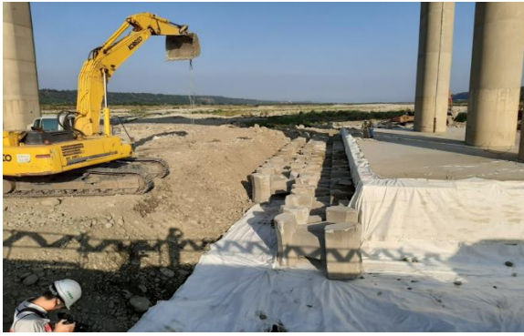
圖 2.35 鼎型塊吊放與排置作業
