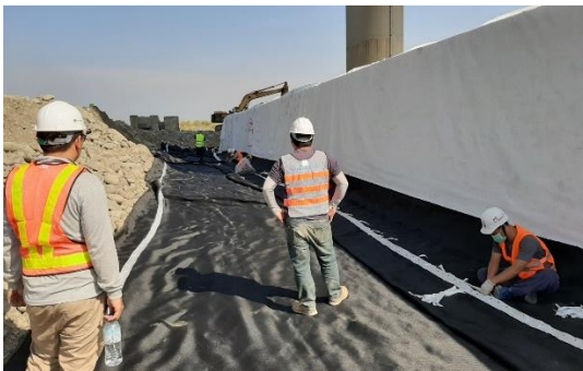
圖 2.33 平面高強度織布鋪設及單元間之綁紮作業
