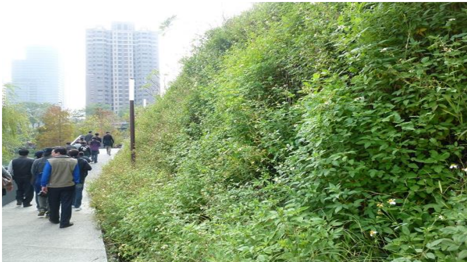
圖 2.2 採用回包式加勁擋土牆之暨南大學邊坡
