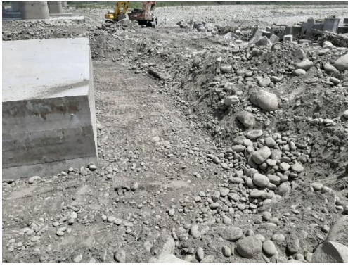
圖 2.29 橋墩基礎上游整地
