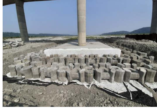
圖 2.36 鼎型塊結合地工織布保護工鋪設完成(下游側)
