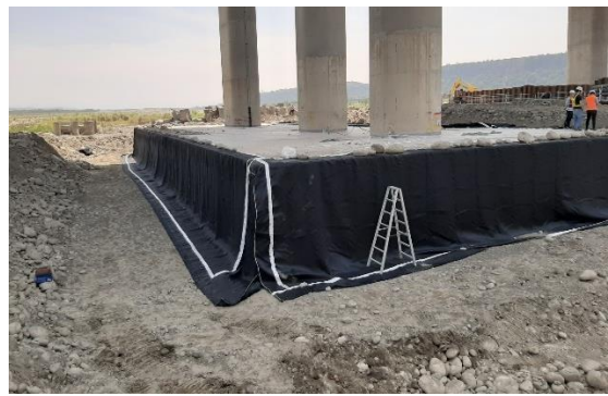
圖 2.32 完成樁帽四周之高強度織布吊放展開及固定
