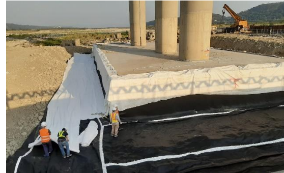
圖 2.34 防護層織布鋪設
