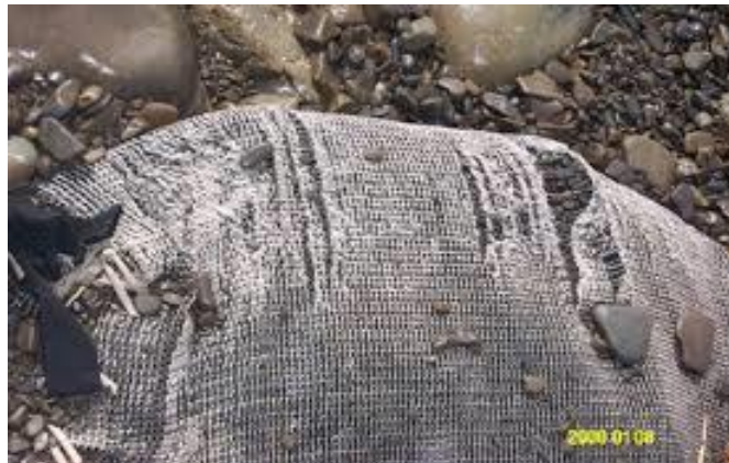
圖 2.5 箱籠受到海岸礫石之往復磨損而破壞
