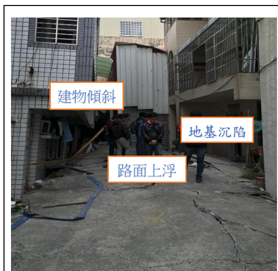
圖 2.2 2016 年 美濃地震臺南市安南區民宅因土壤液化災損狀況
