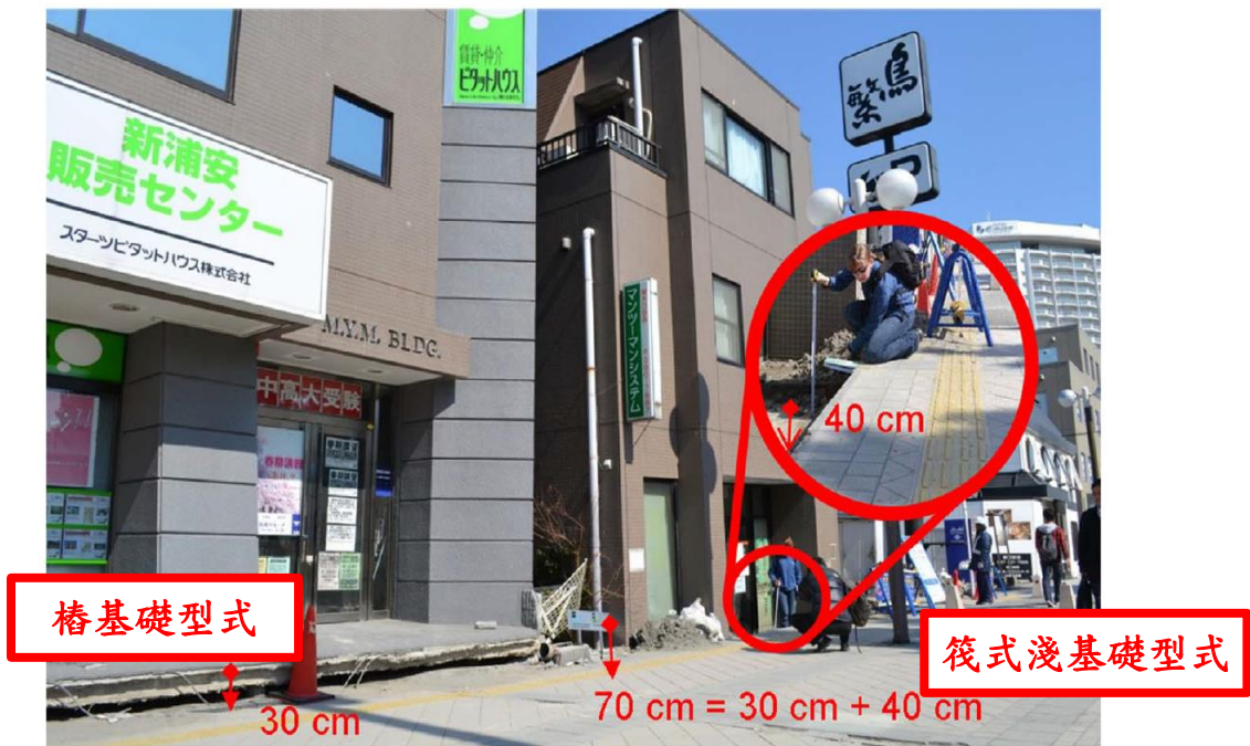
圖 2.9 東北地震後建築物不同基礎形式液化後引致沉陷量差異 [36]
