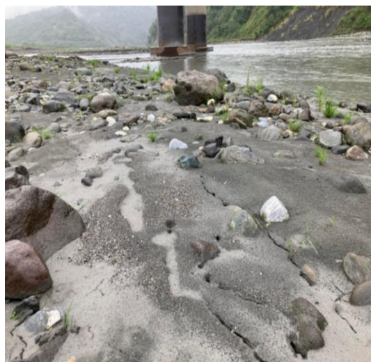
圖 2.3 2022 年 長濱地震花蓮縣玉里舊鐵橋北側，小規模液化現象
