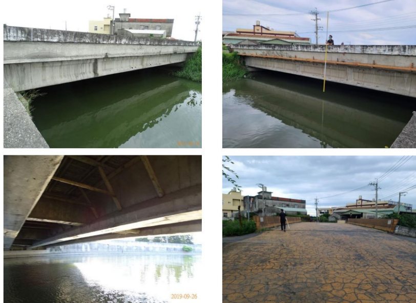
圖 5.31 第 3 次實地測試選址彰化縣福興鄉-出水橋
