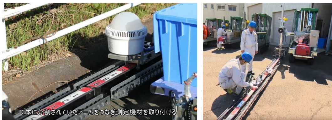
圖 2.18 検測臂組立作業情形
