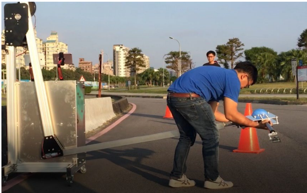
圖 3.36 「推車型橋梁檢測設備」組裝(三)
