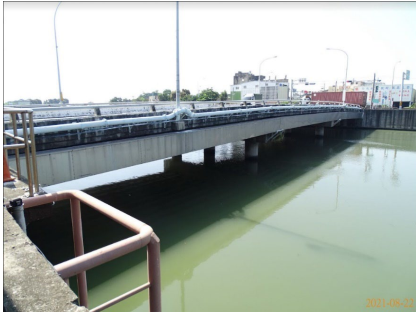
圖 2.55 橋梁外側附掛物及路燈
