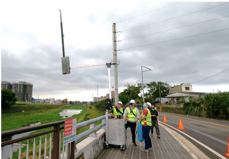
圖 3.44 第二代「推車型橋梁檢測設備」操作情形
