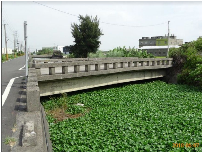
圖 1.2 彰化線西田尾排水 8 號橋
