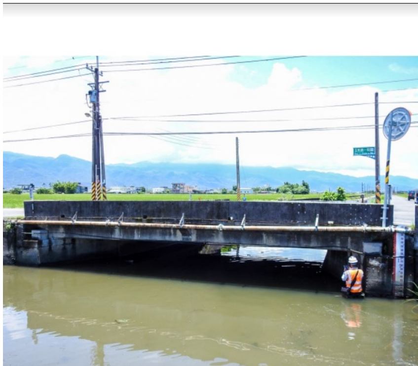
圖 1.3 橋檢人員涉水檢測
