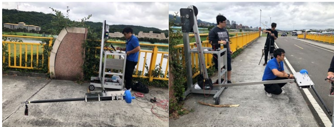
圖 3.33 「推車型橋梁檢測設備」組立完成情形
