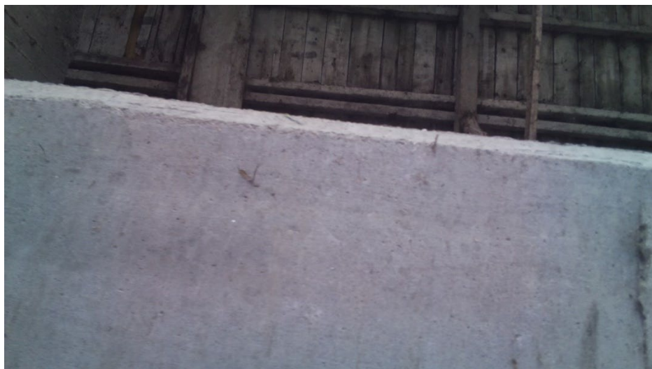
圖 5.34 「出水橋」實地測試梁底影像
