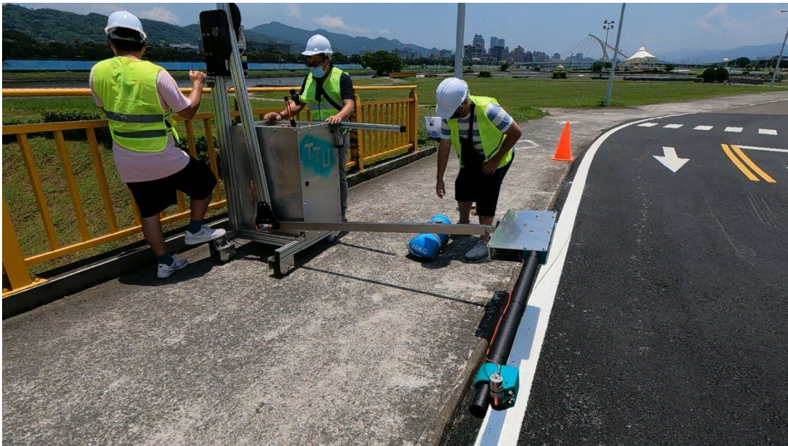
圖 5.11 設備安裝完畢
