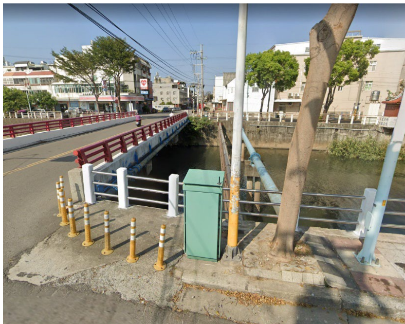
圖 2.56 橋梁旁的管線設施及上方的電線
