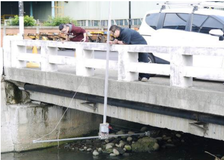
圖 3.16 利用步進馬達將 C 桿推入橋梁底部
