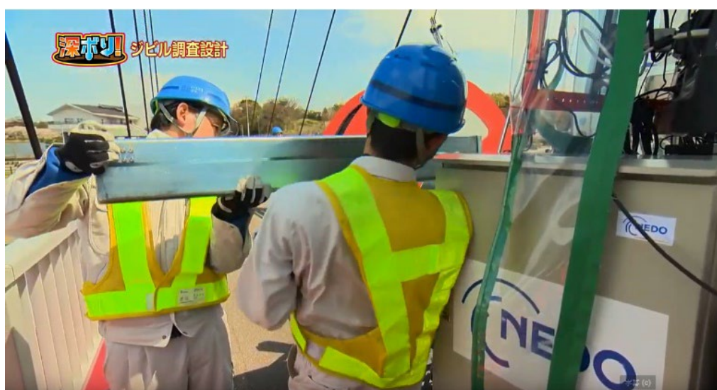
圖 2.20 水平延伸臂組立作業情形
