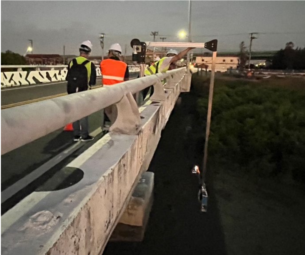
圖 5.35 「福寶橋」實地測試情況
