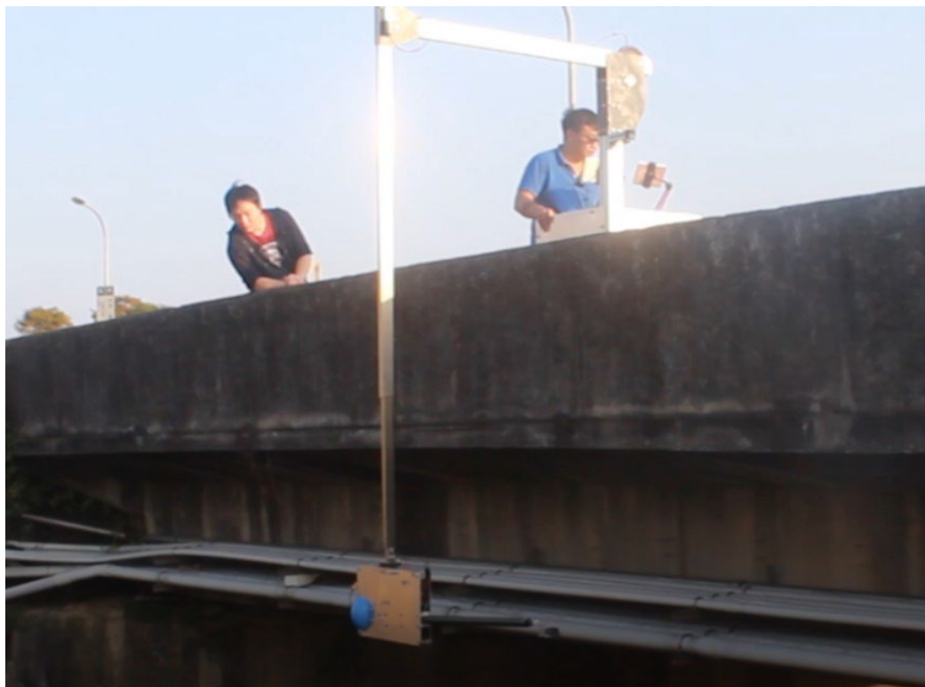
圖 3.38 「推車型橋梁檢測設備」操作(二)
