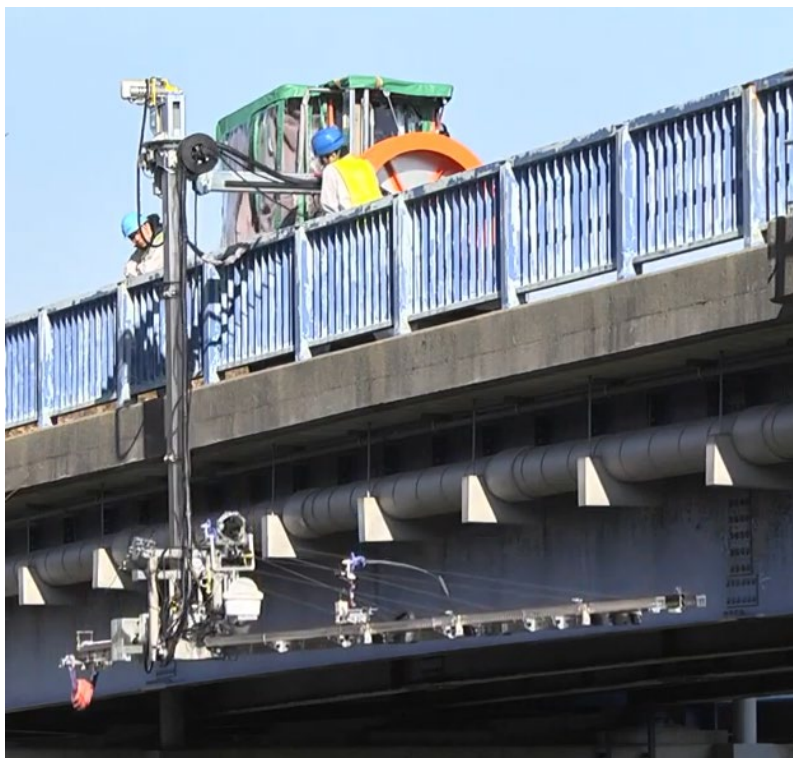
圖 2.29 Zivil 機械手臂型橋梁檢測車實際作業情形(一)
