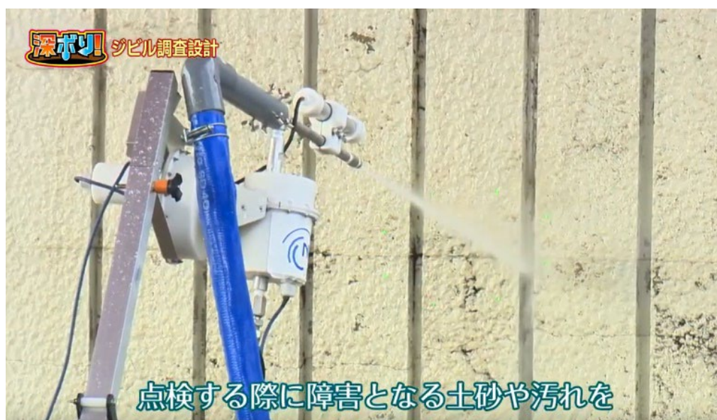
図 2.26 高圧水柱清除髒汚
