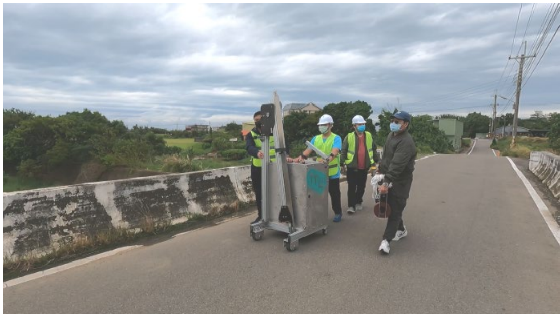
圖 3.41 第二代「推車型橋梁檢測設備」推送情形
