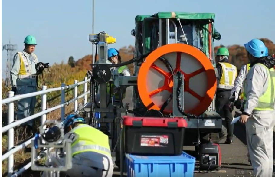
圖 2.21 Zivil 機械手臂型橋梁檢測車組立作業情形
