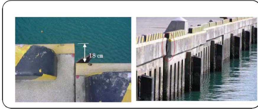
圖 3.2 岸壁法線凹凸案例
