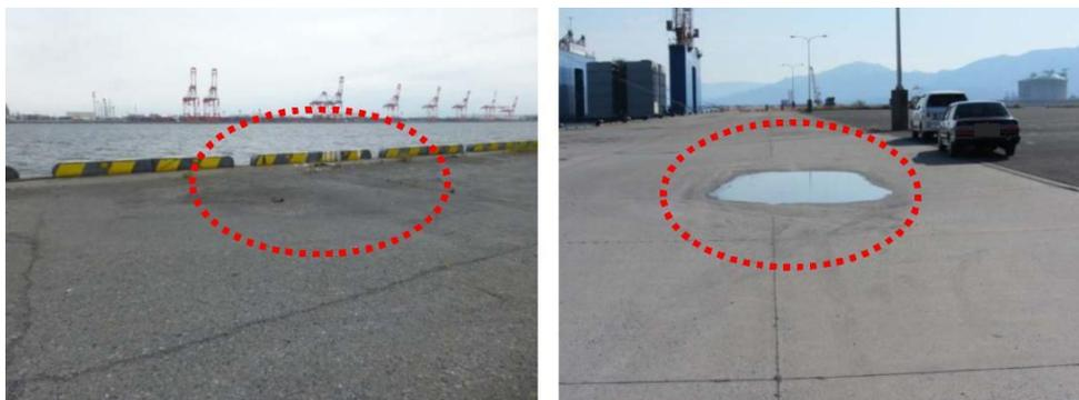
圖 3.3 鋪面下陷/沉陷案例（左瀝青鋪面、右混凝土鋪面）
