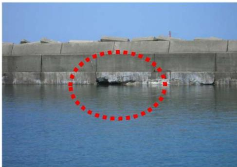
(混凝土方塊的缺損)
