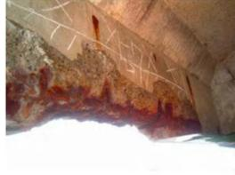
圖 3.18 棧橋上部工(底面)梁的劣化損傷案例
