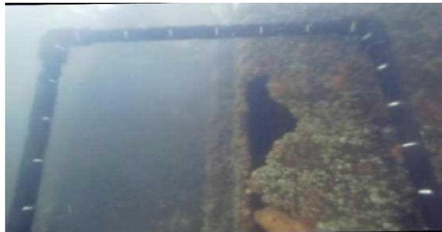
圖 4.5 鋼板樁腐蝕調查<sup>[6]</sup>
