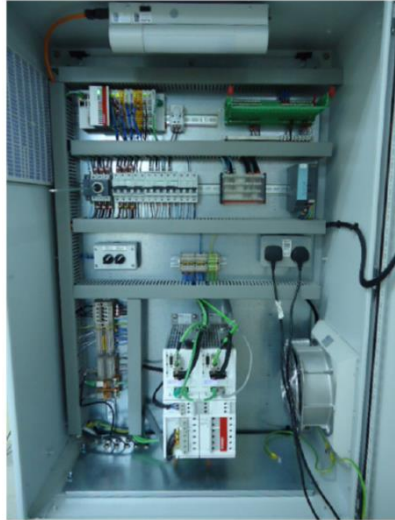
圖 5.7 典型的馬達驅動控制面板(MDCP)內部配置情形
