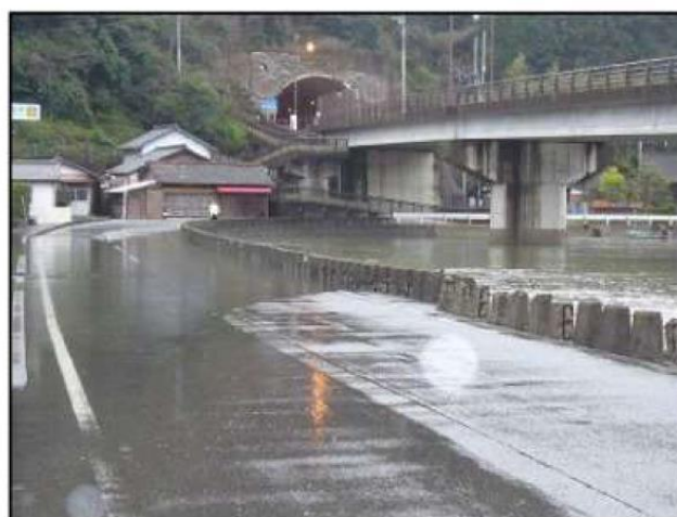
圖 3.6 熊本縣天草下島崎津地區海岸公路溢淹情形(仲井，2013)
