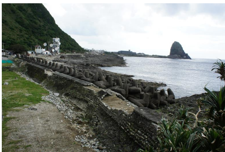
圖 3.10 2012 年天秤颱風造成蘭嶼開元港南側海堤破壞
