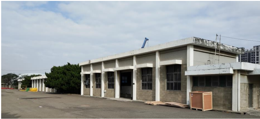
圖 5.1 交通部運輸研究所運輸技術研究中心風洞實驗室
