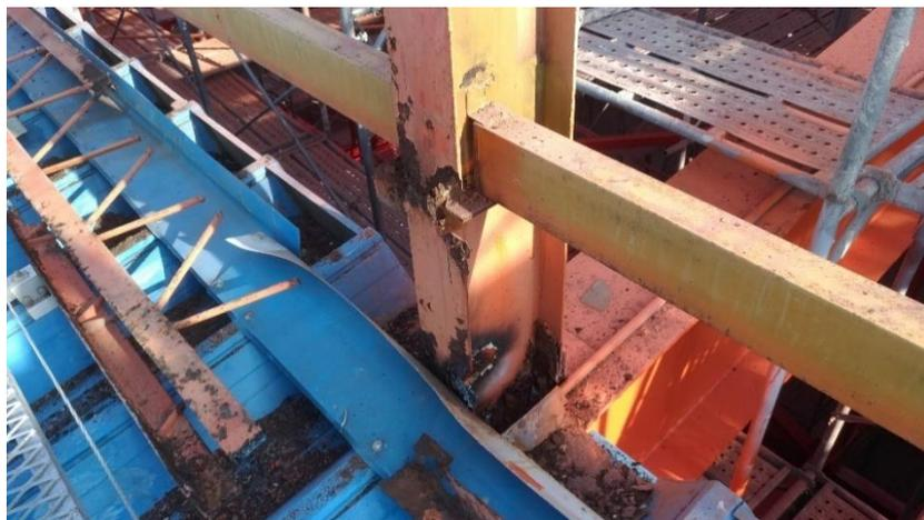
圖 6.1 106 年二廠棚北側屋頂鋼構嚴重鏽蝕
