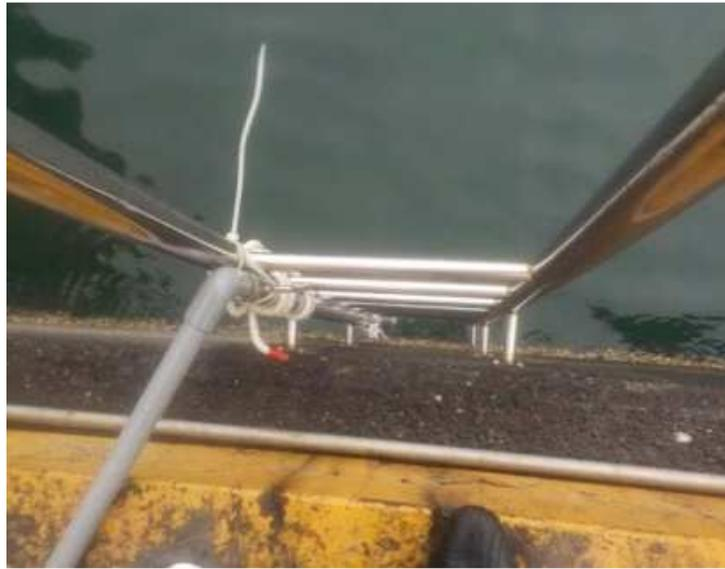
圖2.27 壓力計架設及防碰撞不鏽鋼管爬梯
