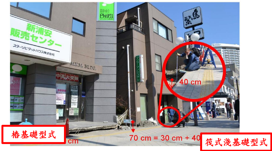
圖 2.9 東北地震後建築物不同基礎形式液化後引致沉陷量差異
