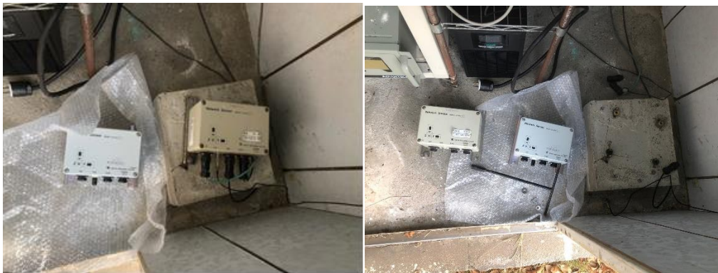
圖 6.1 高雄港舊地震儀(CV373 型)拆除示意圖
