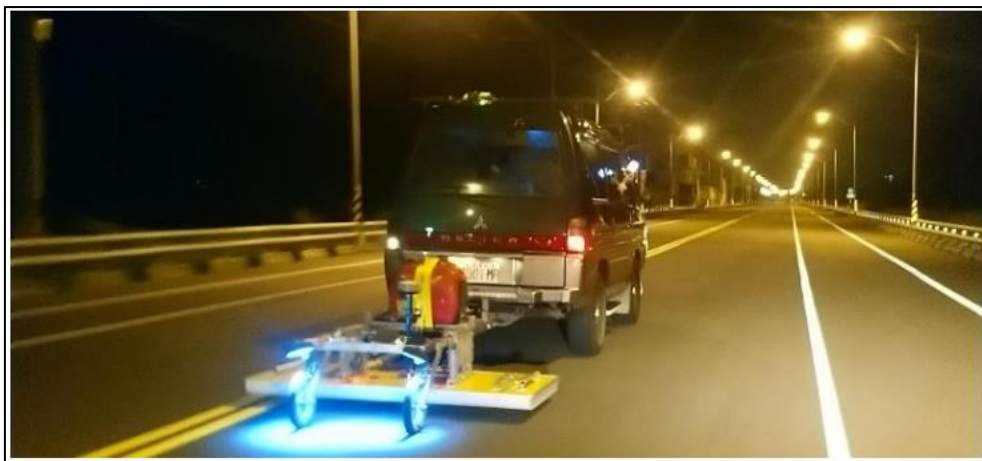
圖 4.7 三維透地雷達檢測現場作業情形 [37]
