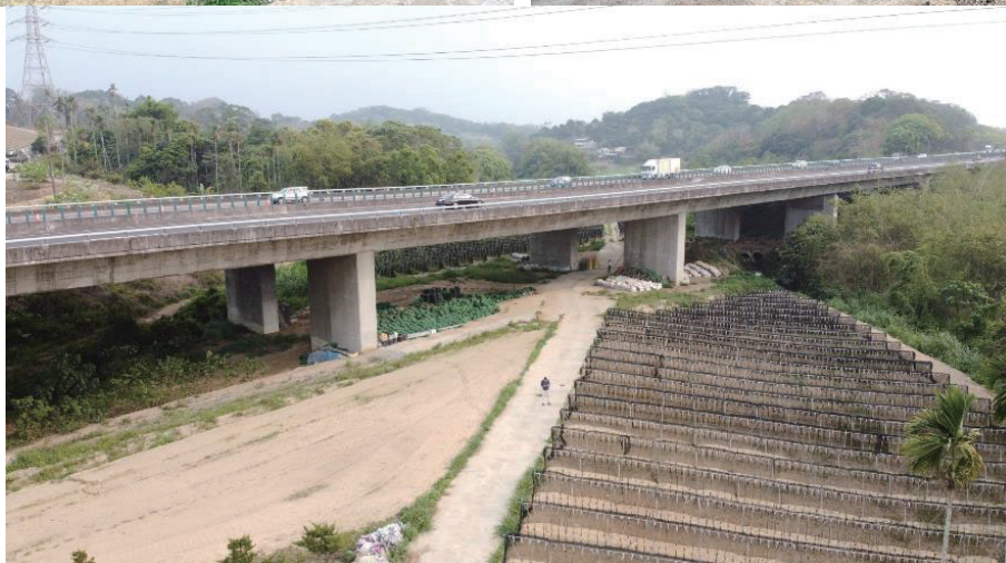
圖 4.152 國道測試場域橋梁場勘-嘉義縣國道 3 號內埔子水庫一號高架橋
