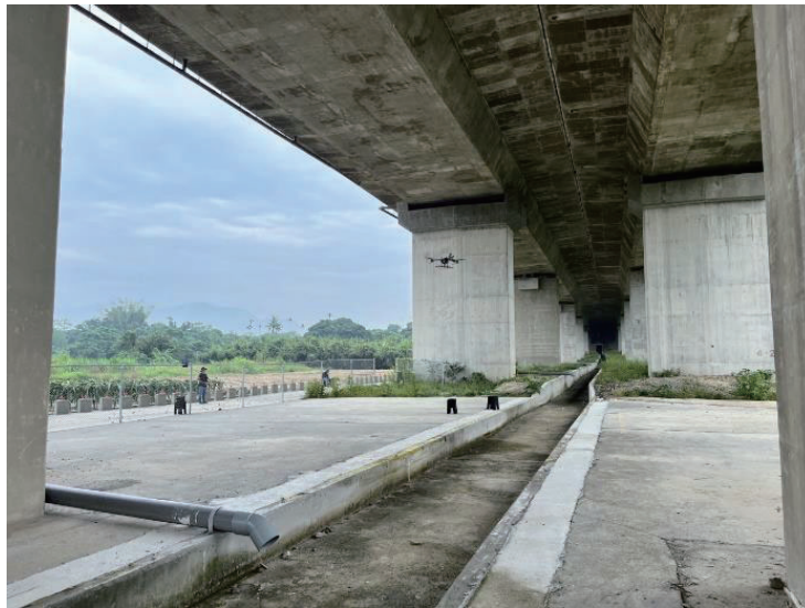
圖 4.108 帽梁(2)(P4-1、PC4-1、P4-2、PC4-2)拍攝作業照片(1)
