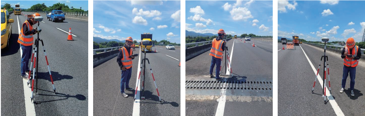
圖 4.28 路面進行 RTK 測量控制/檢核點
