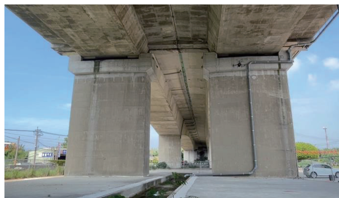
圖 4.103 帽梁(1)(P3-1、PC3-1、P3-2、PC3-2)拍攝作業照片(1)
