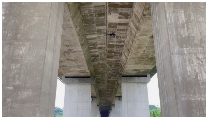
圖 4.85 中間橋面板及大梁側邊(1)(S4G1&S4B2) 拍攝作業照片
