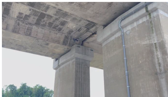
圖 4.94 中間橋面板邊緣(2)(S4B2 & S4B3)拍攝作業照片
