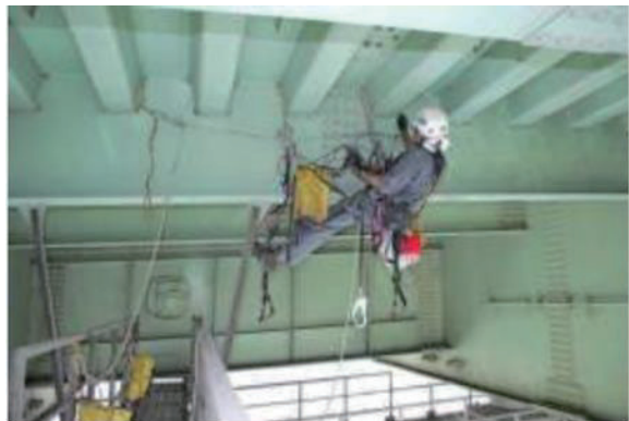
圖 2.1 以人員吊掛方式進行橋梁檢測或修補
