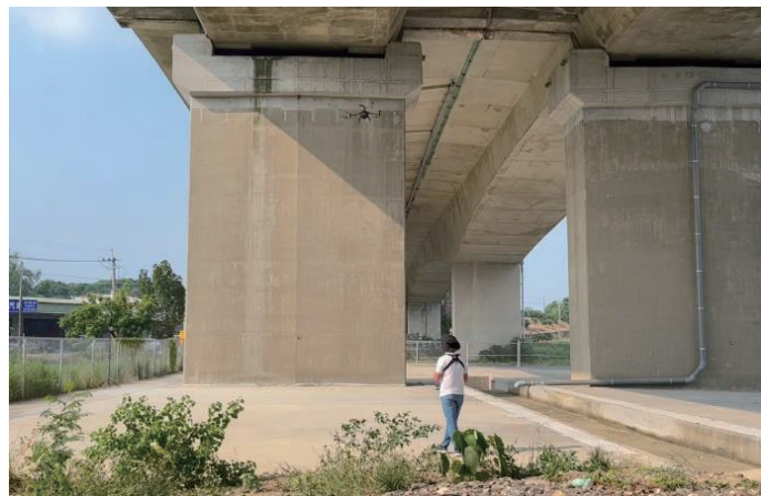
圖 4.105 帽梁(1)(P3-1、PC3-1、P3-2、PC3-2)拍攝作業照片(2)
