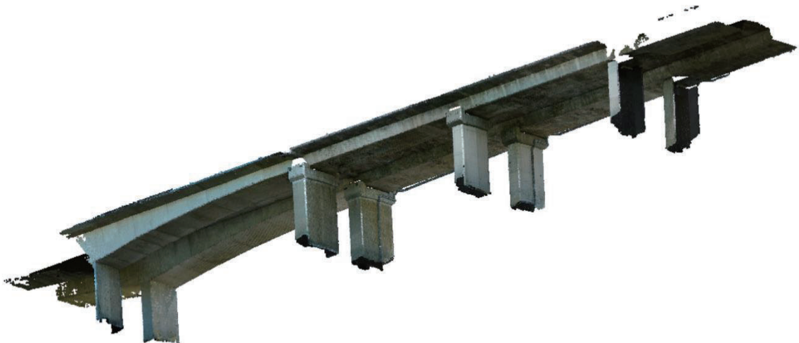
圖 4.38 地面光達掃描成果(刪除非橋梁點雲)
