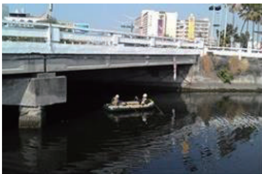
圖 2.2 使用橡皮艇或橋梁專用檢測車進行橋梁檢測
