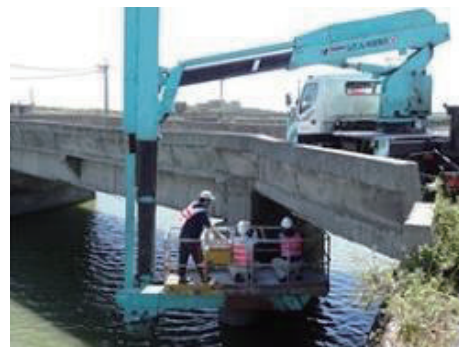
圖 2.2 使用橡皮艇或橋梁專用檢測車進行橋梁檢測
