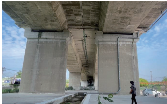
圖 4.91 中間橋面板邊緣(1)(S4B2&S4B3)拍攝作業照片
