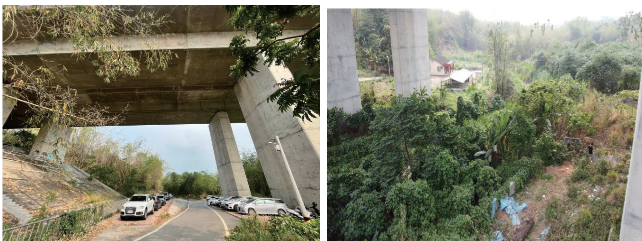
圖 4.150 國道測試場域橋梁場勘-嘉義縣國道 3 號葉子寮溪河川橋
