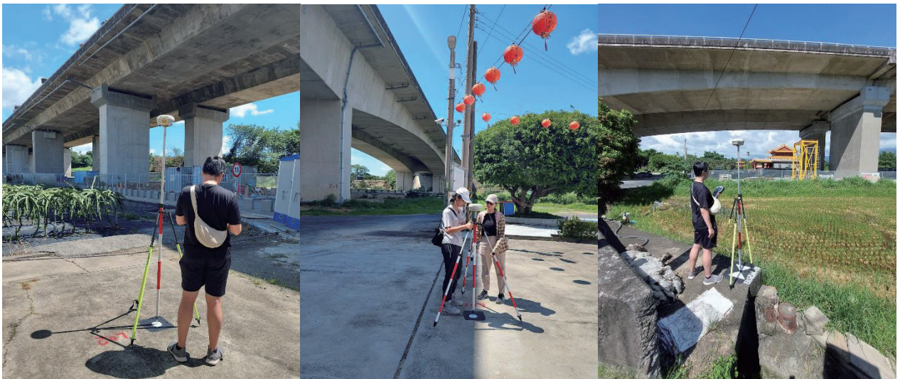
圖 4.29 橋下附近進行 RTK 測量控制/檢核點
