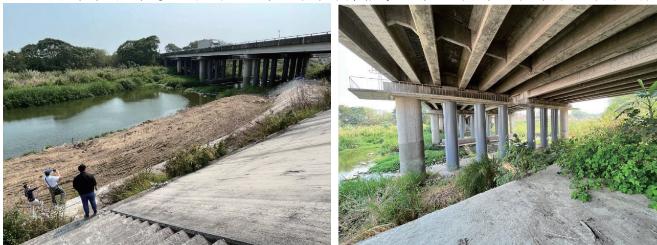
圖 4.149 國道測試場域橋梁場勘-嘉義縣國道 1 號牛稠溪橋
