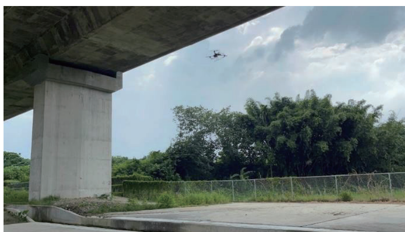
圖 4.82 南向大梁(S4G2)拍攝作業照片
