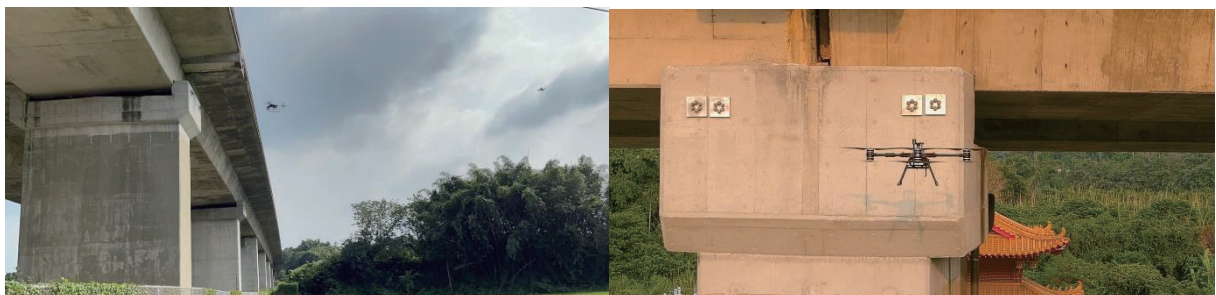
圖 4.100 南向橋面板(S4G2&S4B4)拍攝作業照片
