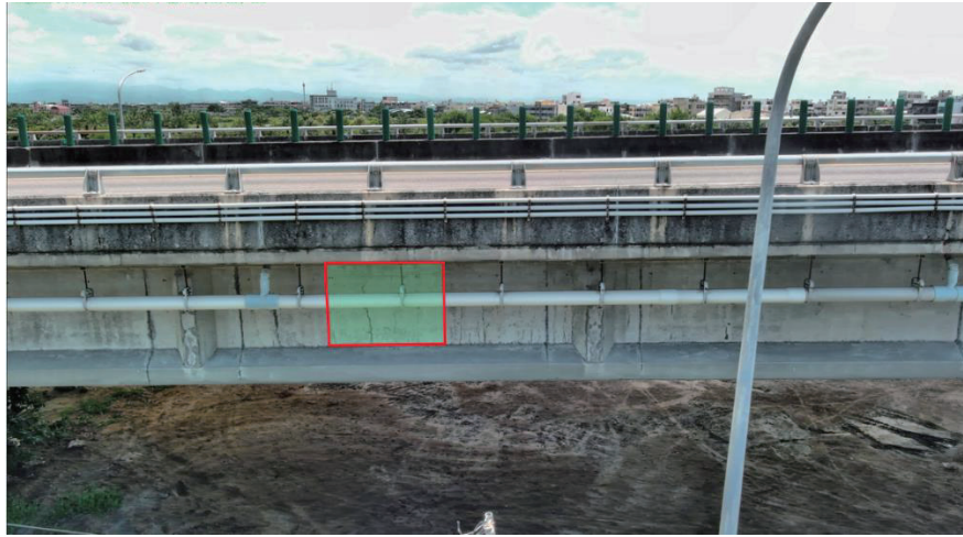
圖 3.27 無人機拍攝之原始影像套疊某一矩形框之示意圖
