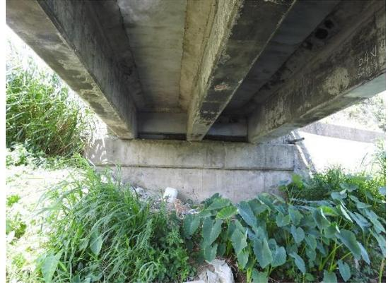
2D3-1, 2D3-2 橫隔梁混凝土修補
