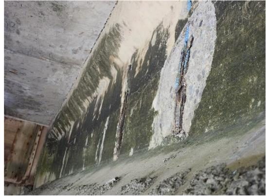
主梁混凝土剝落、鋼筋外露
