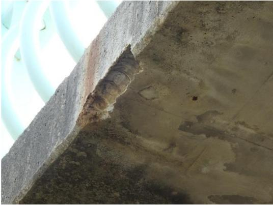
S01 橋面板(懸臂板處)混凝土剝落
