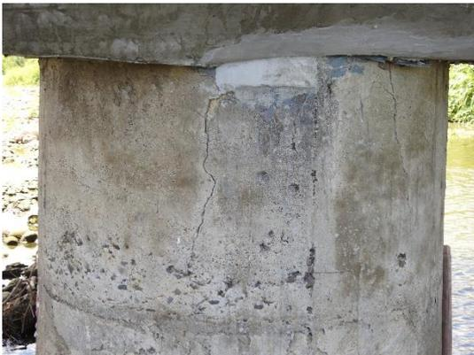
Defect #6 橋墩混凝土裂縫
