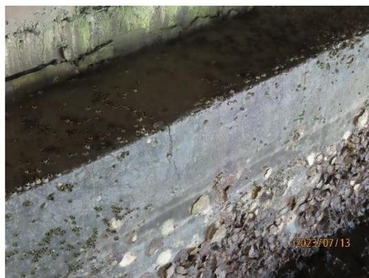
Defect #7 橋台混凝土裂縫
