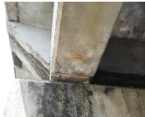
Defect #4 主梁混凝土裂縫
