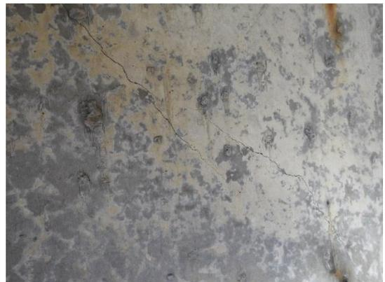
Defect #5 橫隔梁混凝土裂縫
