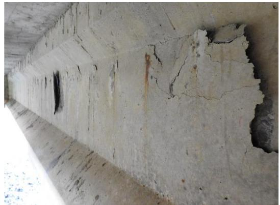
主梁腹板層隙、剝落
