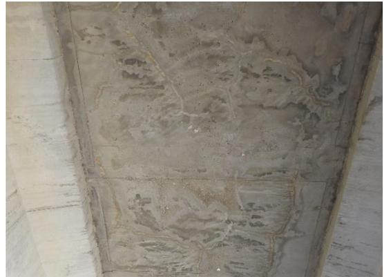
S02-S03 橋面板混凝土裂縫、滲水白華
