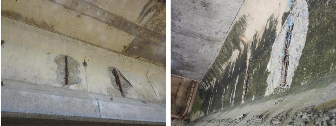
圖 4.1 橋梁代號 07 預力混凝土主梁鋼筋外露銹蝕情形(缺陷編號 03)
