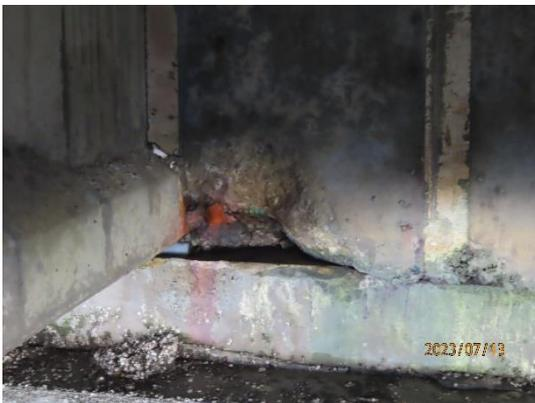
Defect #4 橫隔梁混凝土剝落
