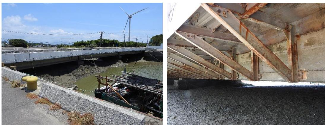
圖 4.2 橋梁代號 07 河道嚴重淤積情形
