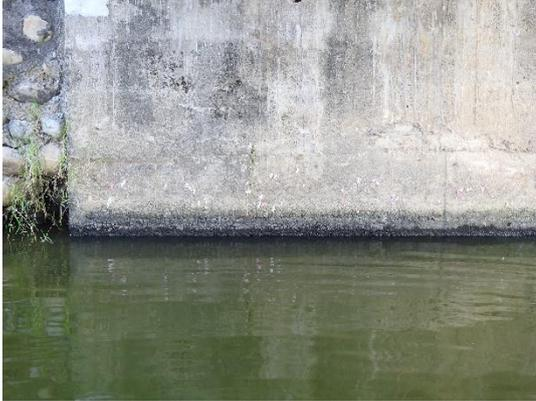
Defect #8 橋台混凝土磨損
