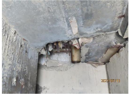
A1、A2 伸縮縫處橋面板混凝土剝落、鋼筋外露
