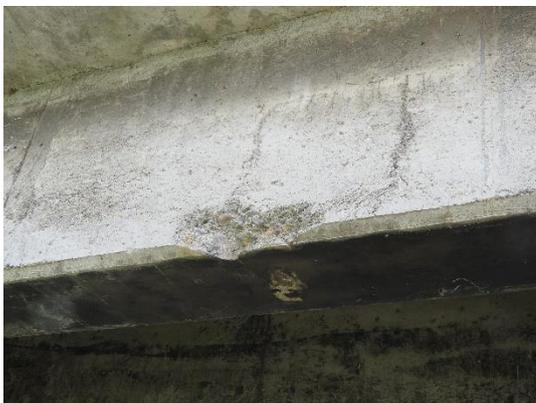
Defect #3 主梁混凝土剝落
