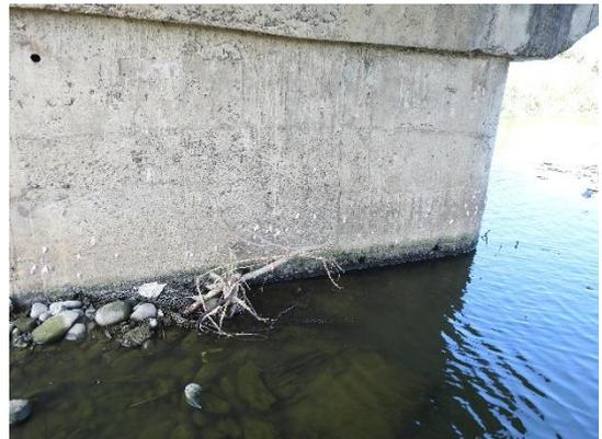
Defect #7 橋墩混凝土磨損
