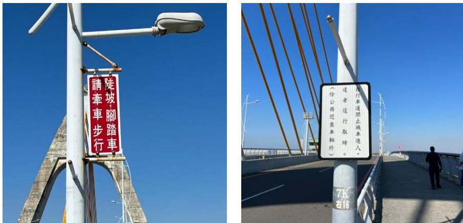
圖 5.4-26 標誌牌面不符道路交通標誌標線號誌設置規則
