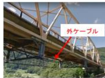
鋼橋の外ケーブル補強の例
