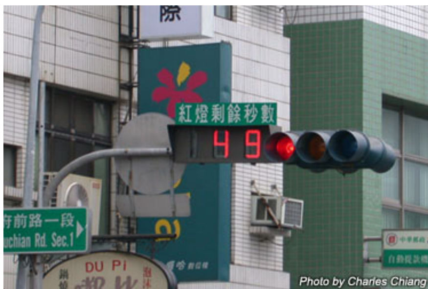
圖 1-3 外掛式紅燈倒數計時顯示裝置設置圖
