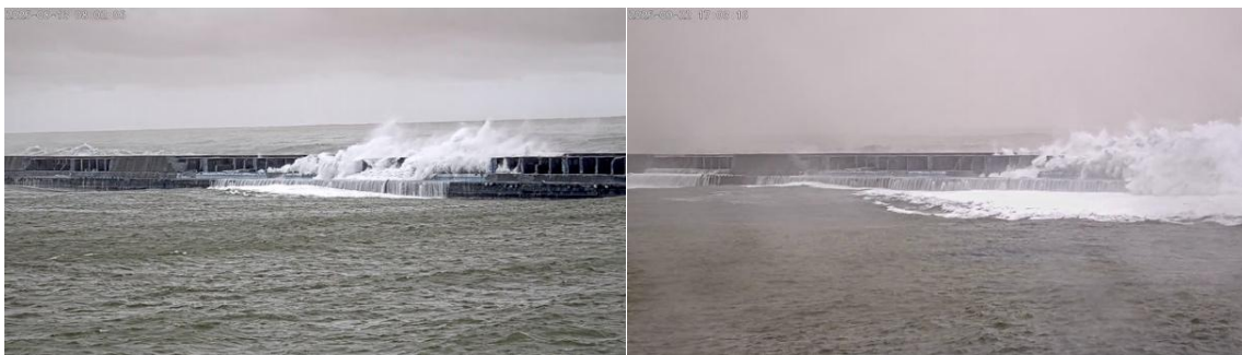
圖 6 2025 年花蓮港區東防波堤越波影像(左：楊柳颱風、右：樺加沙颱風)
