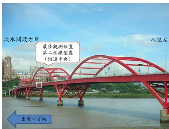
圖 1 表面流速計系統安裝位置示意圖
