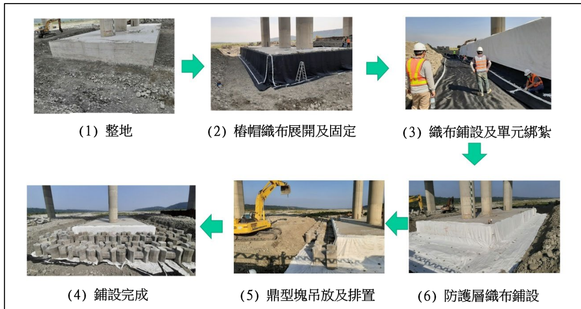
圖 27 鼎型塊織布橋基保護工法施工流程
