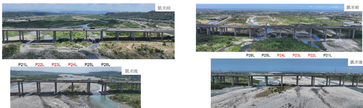
圖 17 凱米颱風前後現場情形(往上游拍攝) 圖 18 凱米颱風前後現場情形(往下游拍攝)
