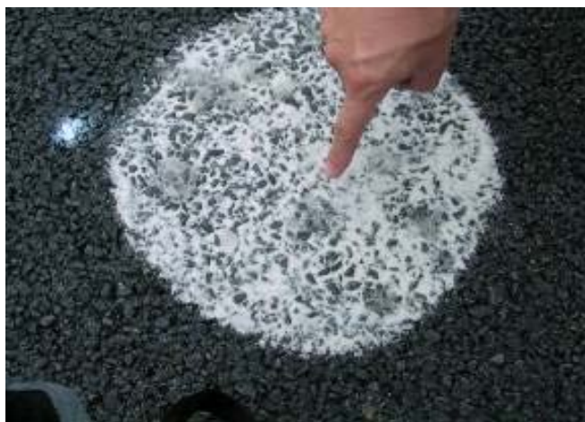
圖 3.10路面潮溼毛細現象而不易鋪平
