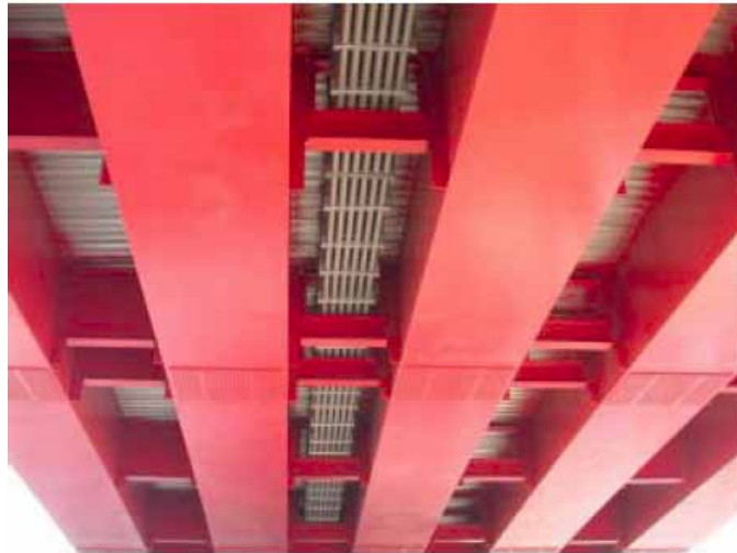
圖4.11 利用外橫隔梁加掛管線
