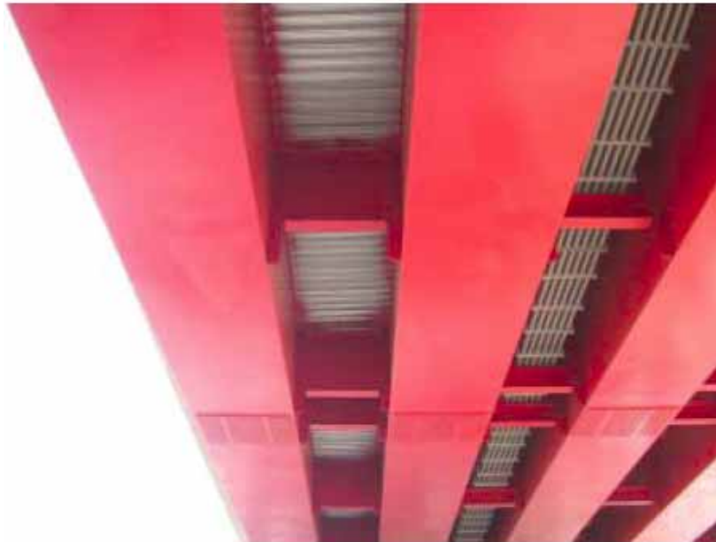
圖4.9典型熱軋鋼梁式之外橫隔梁
