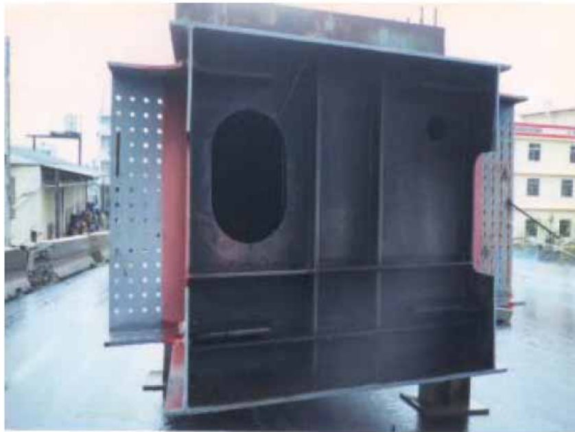
圖 4.5 用於支承處之固定板式端隔梁(預留人孔、檢測孔)
