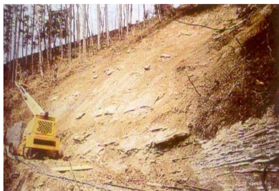
圖 2.11 瑞士山區公路所採用的 PENTFIX 護坡綠化工法
