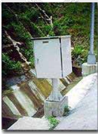
路側之車輛偵測器之終端控制器
