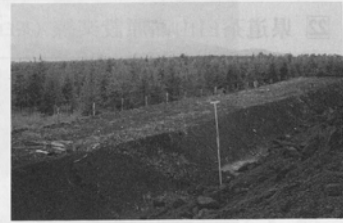
仮置中の表土。仮置地を確保するため道路用地外の新たな土地改変は避ける必要がある。ここでは将来車線を使って表土を仮置している（1983年撮影）
