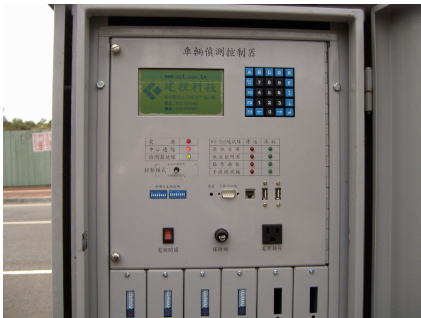
圖 9-3 環路線圈式偵測器內部裝置圖
