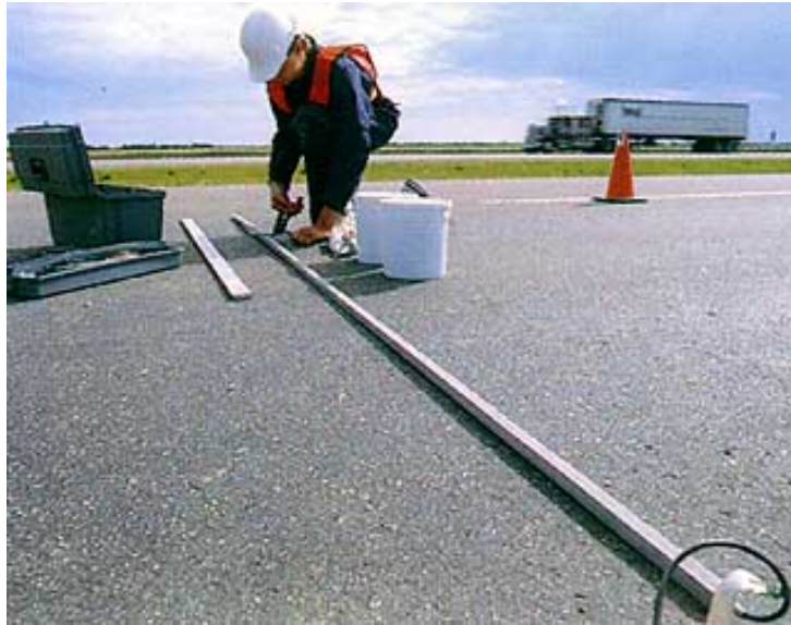
圖 4.11 壓電式車輛偵測器
