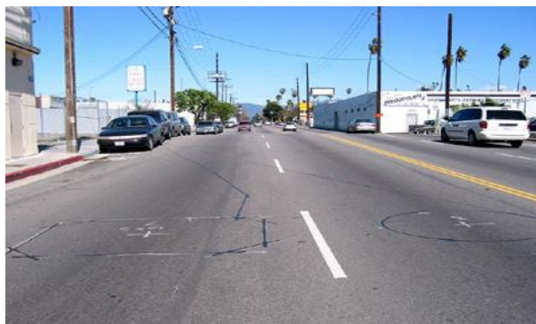
圖 4.8 環路線圈式車輛偵測器
